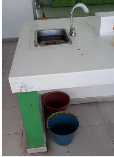
Ilustración 6-1 Fotografía desagüe punto de muestreo.
