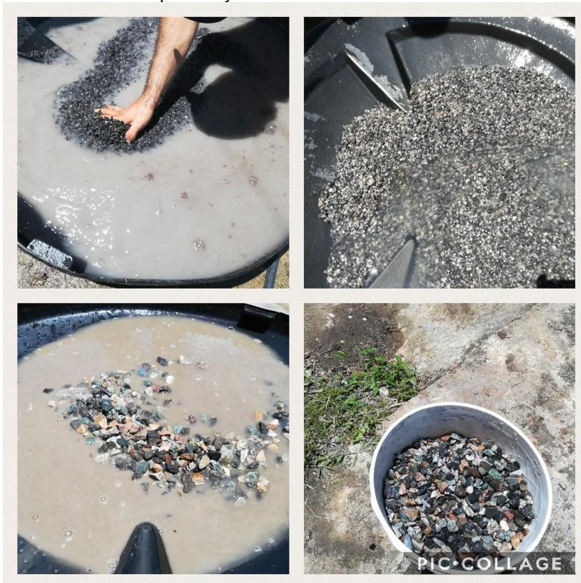
Figura 3. Lavado de grava para sistema de filtración.
