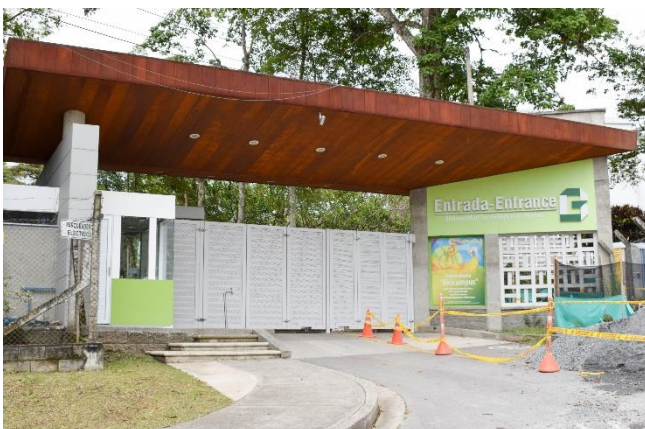
(e) Portería parqueadero Fac. de ingeniería eléctrica
