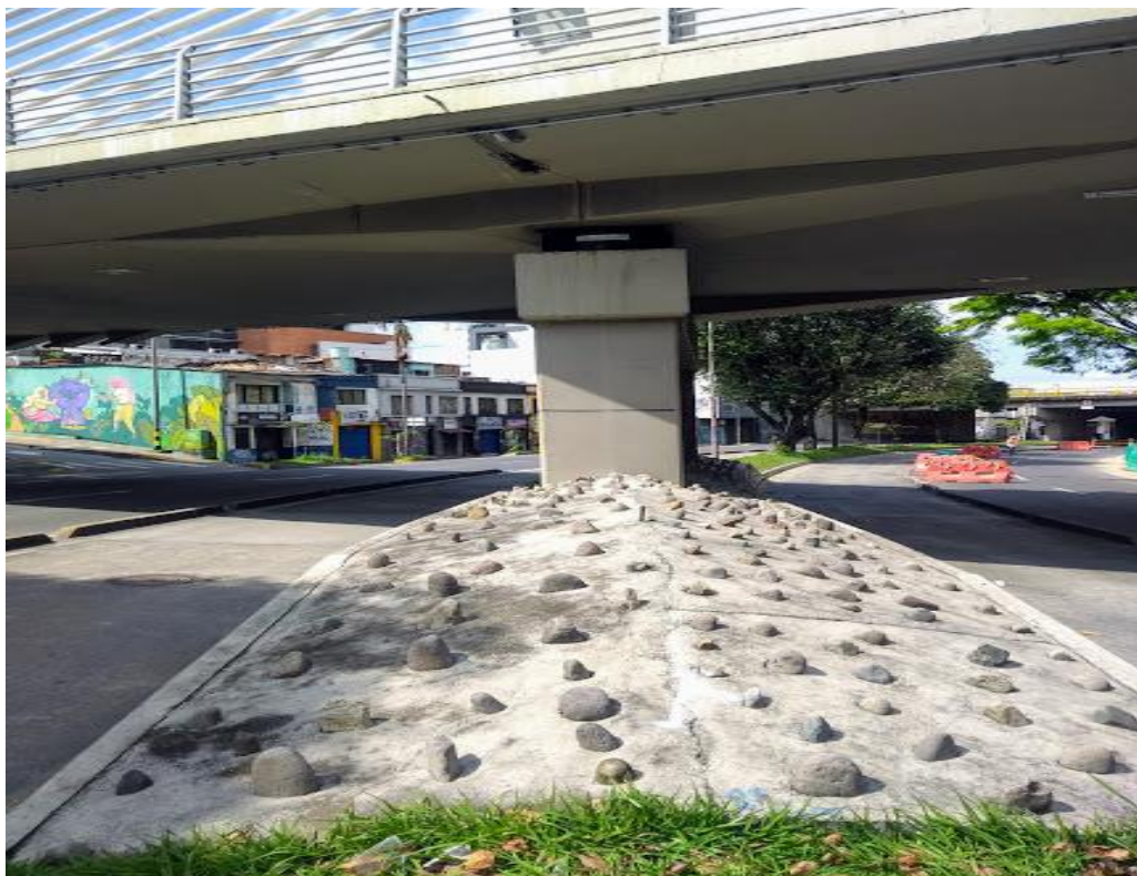
Figura 51. Fotografía de puente “Barranquero” en la ciudad de Pereira. Ejemplo de arquitectura defensiva. Fuente: Archivo personal de la investigación.
