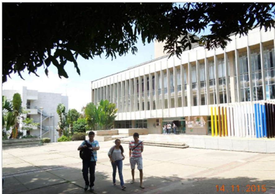
Figura 14. Vista general de la Biblioteca Central UIS, Nivel 1 de intervención. Fuente: PEMP 2015
