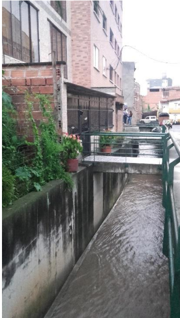
Puentes para cruzar quebrada a las casas
