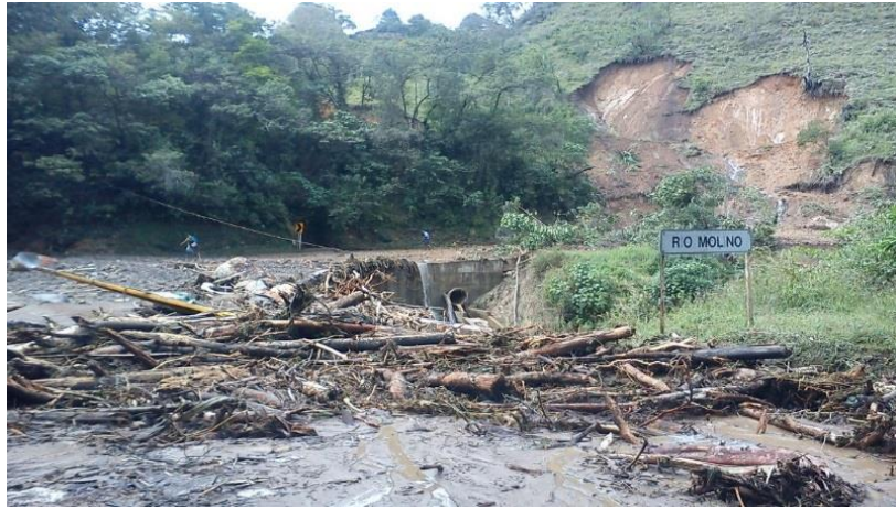
Imagen No. 6- Taponamiento río Molino Km 7.
