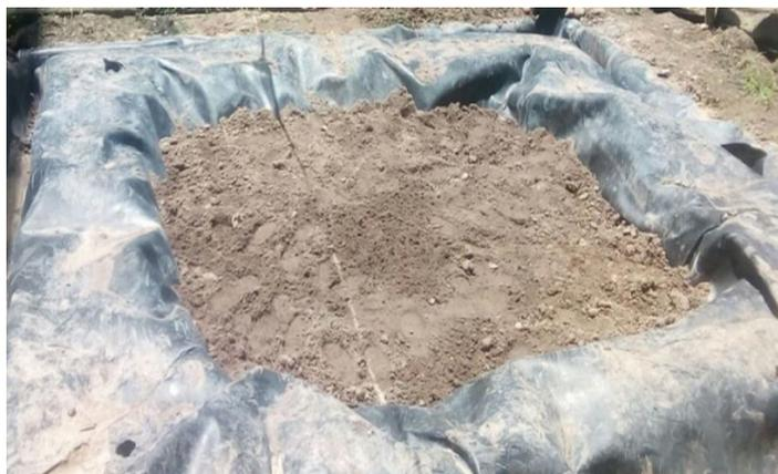
**Figura 2.4** Descarga del lecho de suelo en el humedal subsuperficial experimental implementado de 5m<sup>2</sup> de área.
