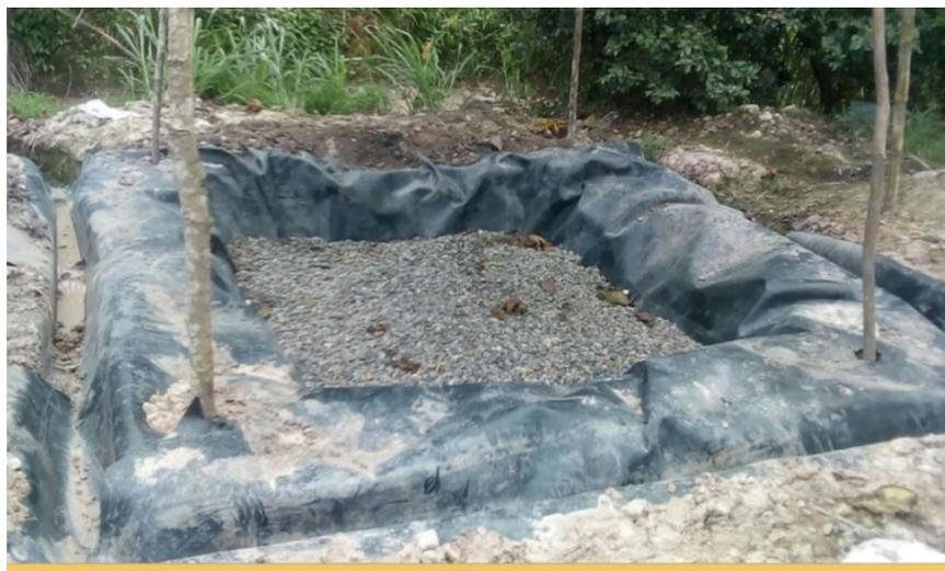
**Figura 2.3** Descarga del lecho de grava en el humedal subsuperficial experimental implementado de 5 m<sup>2</sup> de área.
