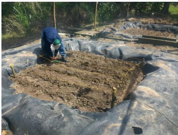
**Figura 2.5** Adecuación del terreno del humedal de 5 m<sup>2</sup> para la siembra de las plántulas de acelga
