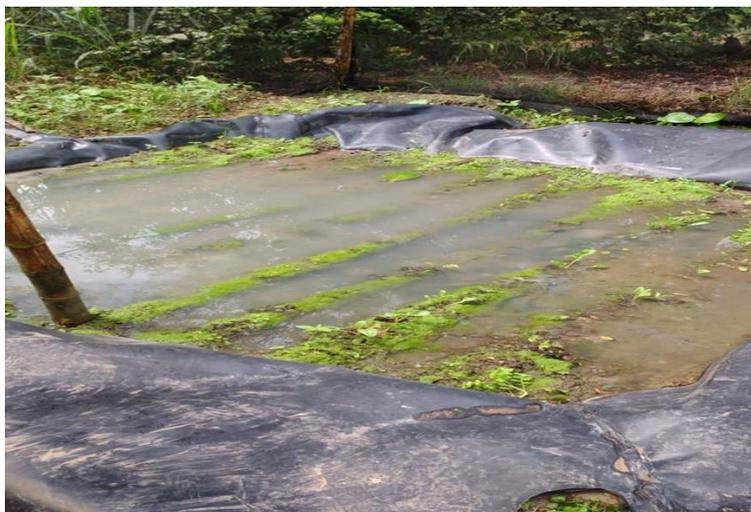
**Figura 3.1** Vista general del humedal subsuperficial de 5 m<sup>2</sup> de área luego de un aguacero
