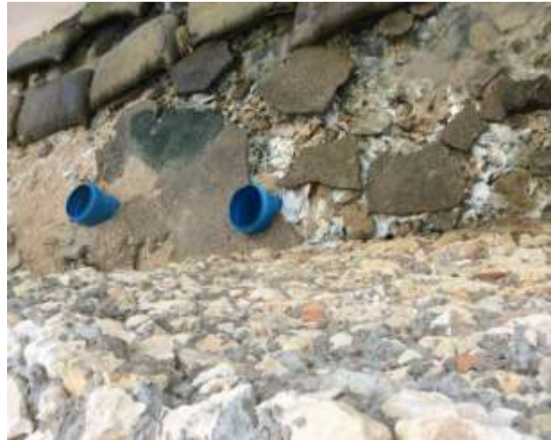
Figura 5 Pozo agua dulce construidos por la comunidad (clausurados)
