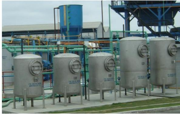
**Ilustración 4 filtro de arena antracita. Fuente: Proton, 2014**
