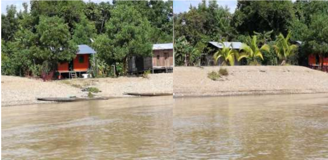
Figura 11. Alteración del terreno cerca de viviendas
