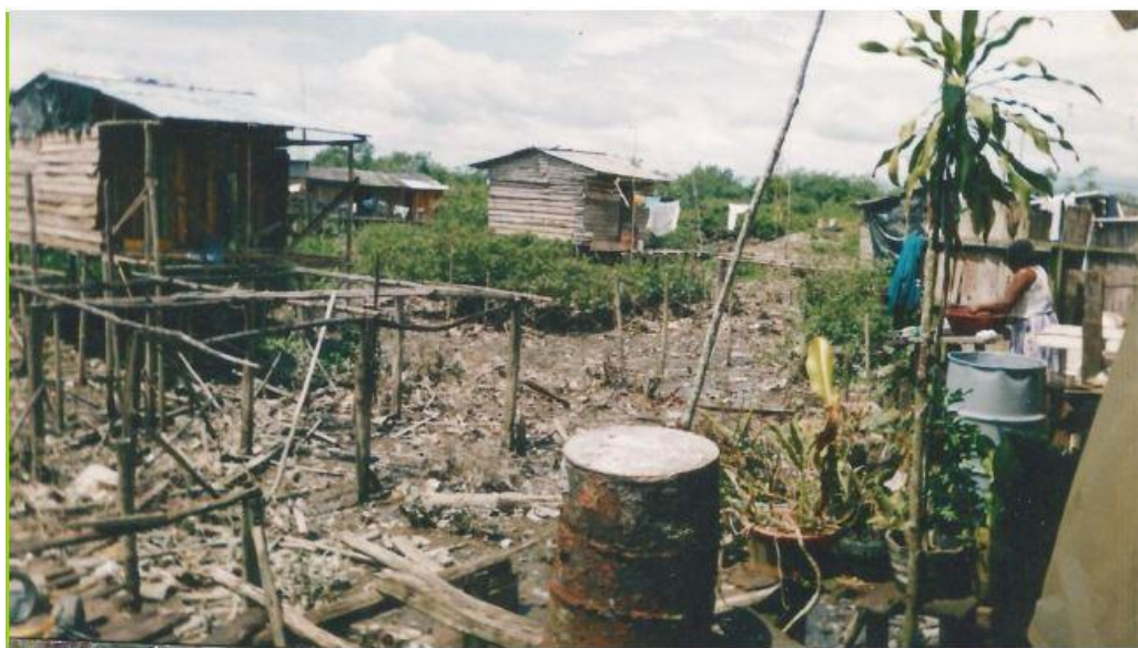
Ilustración 2 Panorámica de viviendas construidas en bajamar
