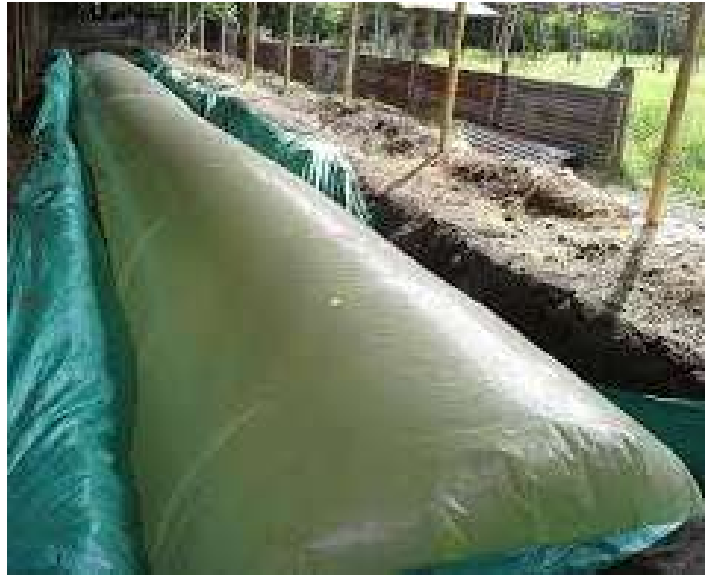
Imagen No. 12 Proceso instalación biodigestor prototipo
