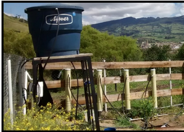
Ilustración 23 Montaje completo del sistema
