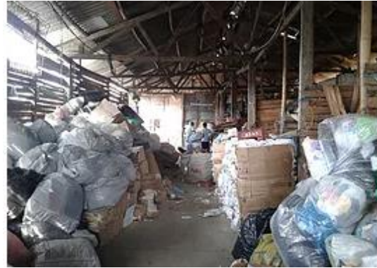
Foto 7. Instalaciones de Aremarpo - Popayán
