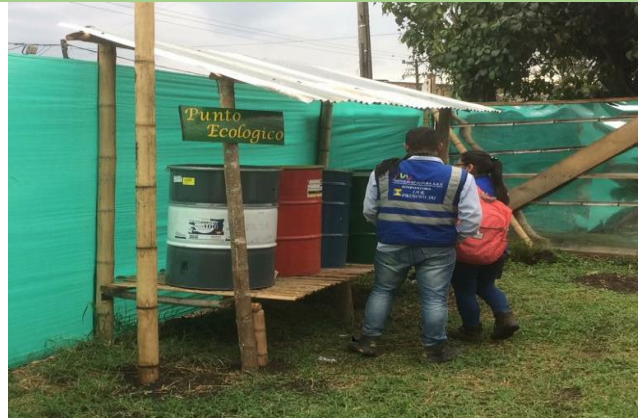
Foto 4. Sistema de separación residuos sólidos –Proyecto vial Transversal 9 – AID barrio el Rincón del Bosque - Popayán
