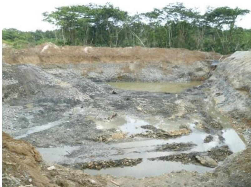
Figura 3-19. Horizontes del suelo intervenidos con el empleo de excavadoras en el municipio de Quibdó
