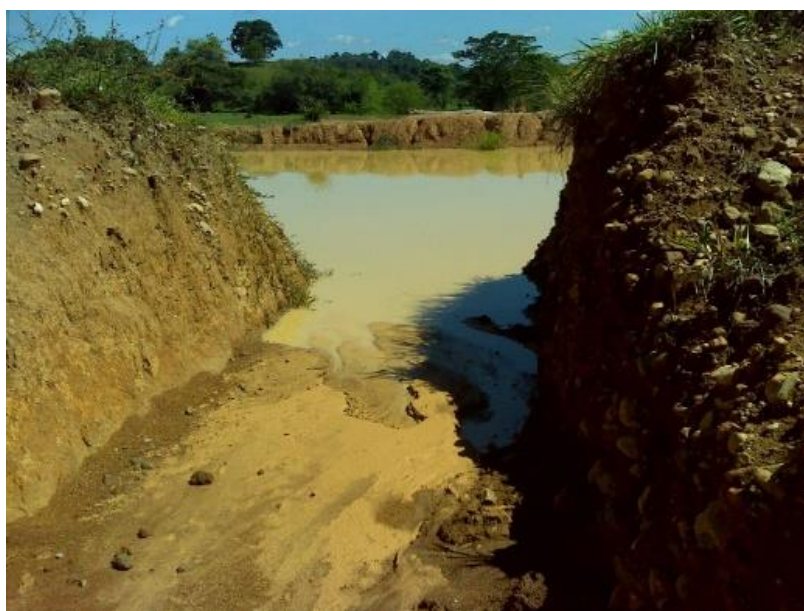
Figura 3-42. Estanque artificial para el depósito de los residuos mineros en Sonsón, Antioquia
