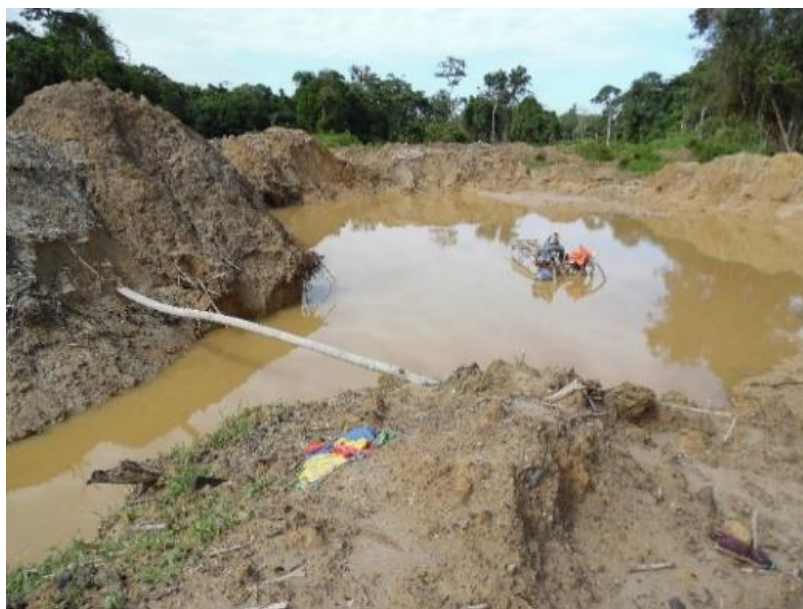
Figura 3-51. Remoción de materiales aluviales en la ronda la quebrada Inanea.
