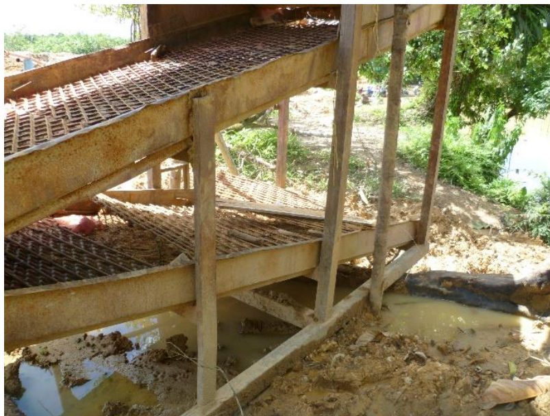
Figura 3-23. Criba provista de canalones con descarga directa de residuos al río Cabi
