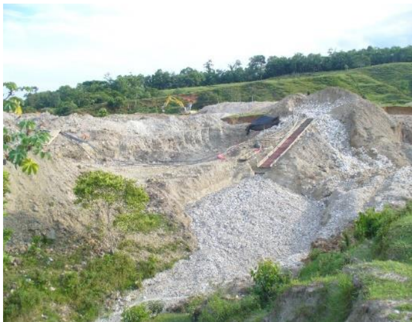
Figura 3-14. Canalón superficial con vertimientos
