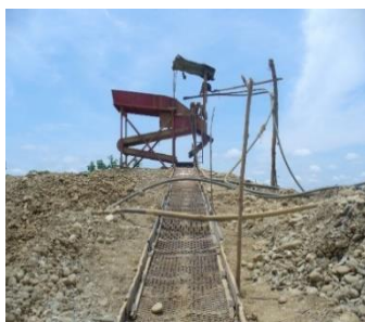
Figura 3-3-1. Criba con canalones en contraflujo y canalón superficial
