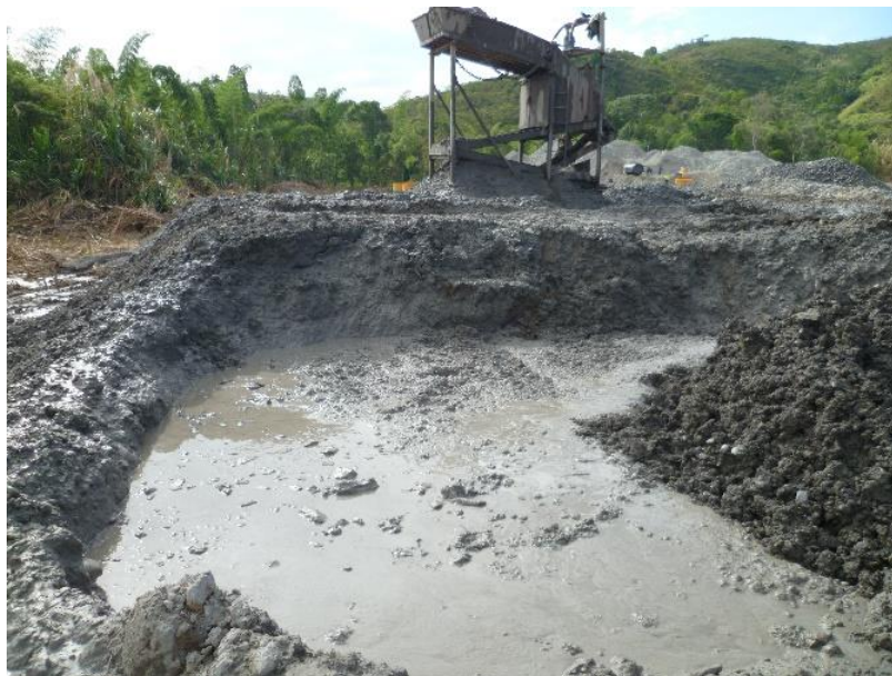
Figura 3-28: Criba con canalones aéreos y superficiales. Los residuos fluyen al río Teta
