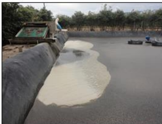
Figura 1-12. Laguna de aireación en el Frigorífico Jongovito
