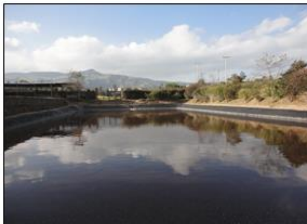
Figura 1-13. Laguna anaerobia en el Frigorífico Jongovito
