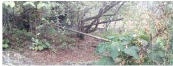
Imagen 8. Línea de Conducción 4", Viaducto Hierro Galvanizado
