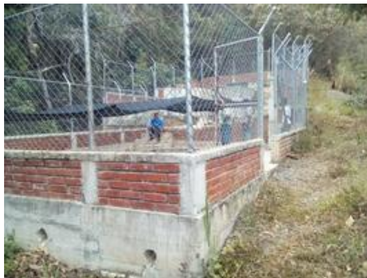
Imagen 6. Cerramiento para estructuras de tratamiento del agua
