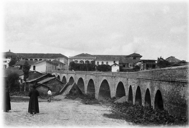
Fotografía 6. Puente de El Humilladero aproximadamente en el año 1930. Fuente: archivo de José María Arboleda C.
