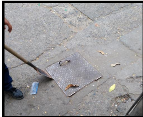
Figura 15. Caja de protección de válvula.
