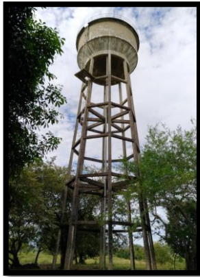
Figura 14. Tanque elevado de compensación.
