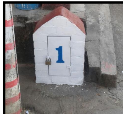
Figura 19. Pila de muestreo para el control y vigilancia de la calidad del agua.
