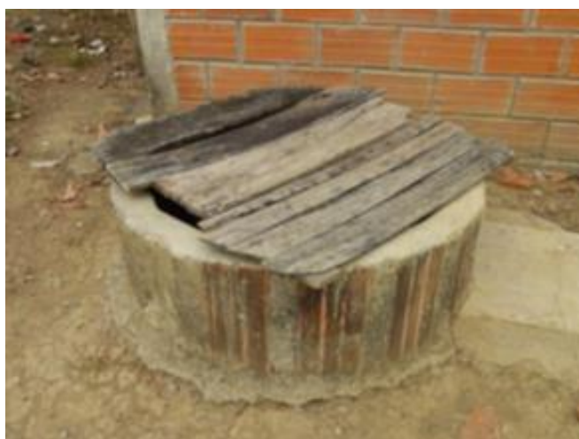
Ilustración 14. Suministro de acueducto en algunas viviendas de El Porvenir.
