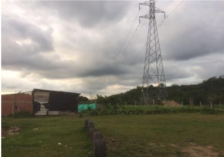
Ilustración 20. Ubicación de viviendas en sector aledaño a torres de energía.
