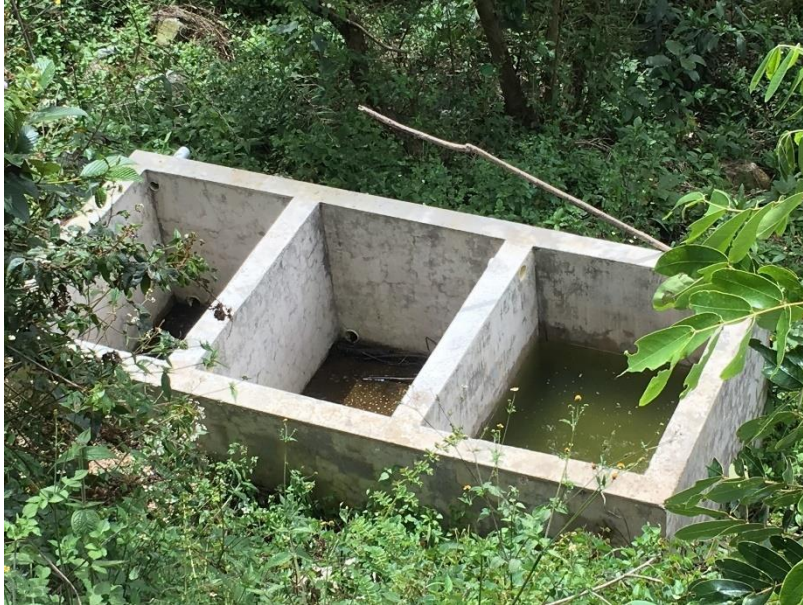
Figura 24. Construcción de tanque de sedimentación de aguas de mina. Fuente: Alianza por la Minería Responsable.
