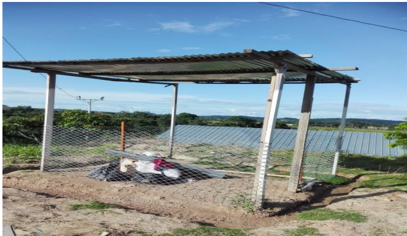
Figura 4. Estructura formada a partir de estantillos y láminas de zinc.
