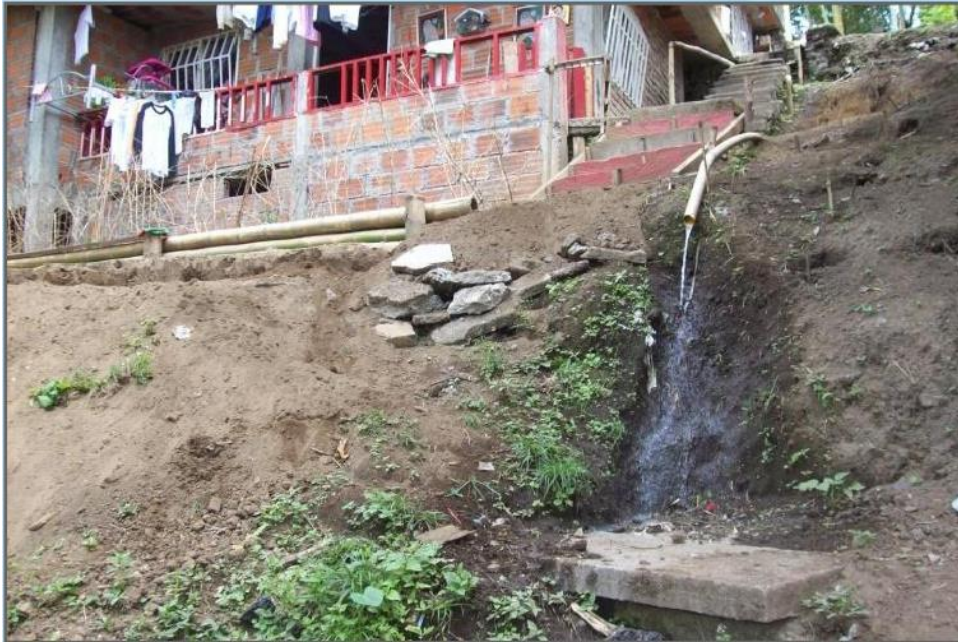
Ilustración 14 - Fotografía barrio de invasión, con inminente peligro de deslizamiento
