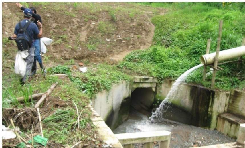
Ilustración 10 - Fotografía Vertedero de aguas residuales
