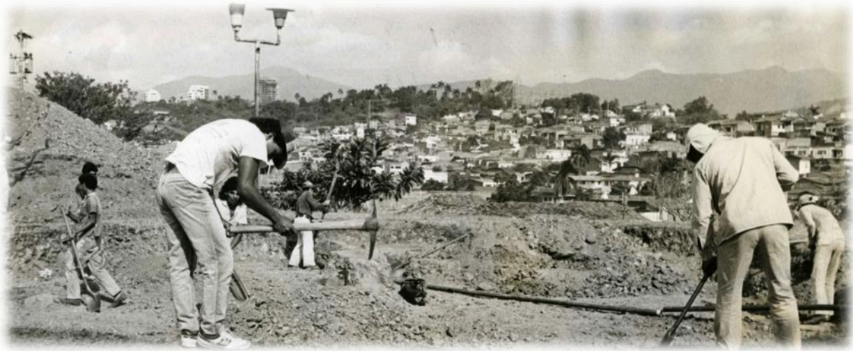
Foto 7. Remoción de tierras para la construcción del parque.
