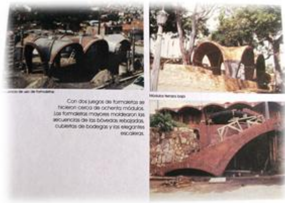
Foto 12. Imágenes de la construcción del parque
