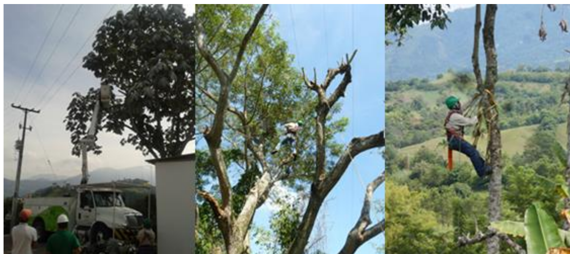
Figura 2: Mantenimiento mecánico y manual de líneas de distribución
