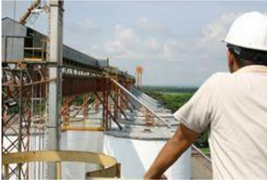
Foto 2. Instalaciones molino Florhuila Campoalegre.
