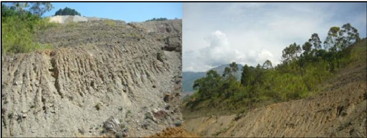
Imagen 4. Áreas de escombrera activa A-3 Fuente: Este estudio.
