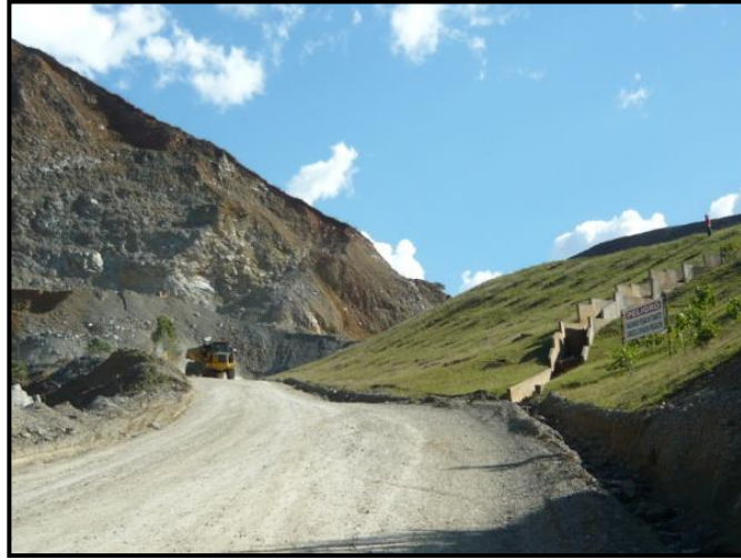
Imagen 6. Áreas intervenidas con obras de infraestructura minera A-5 Fuente: Este estudio.
