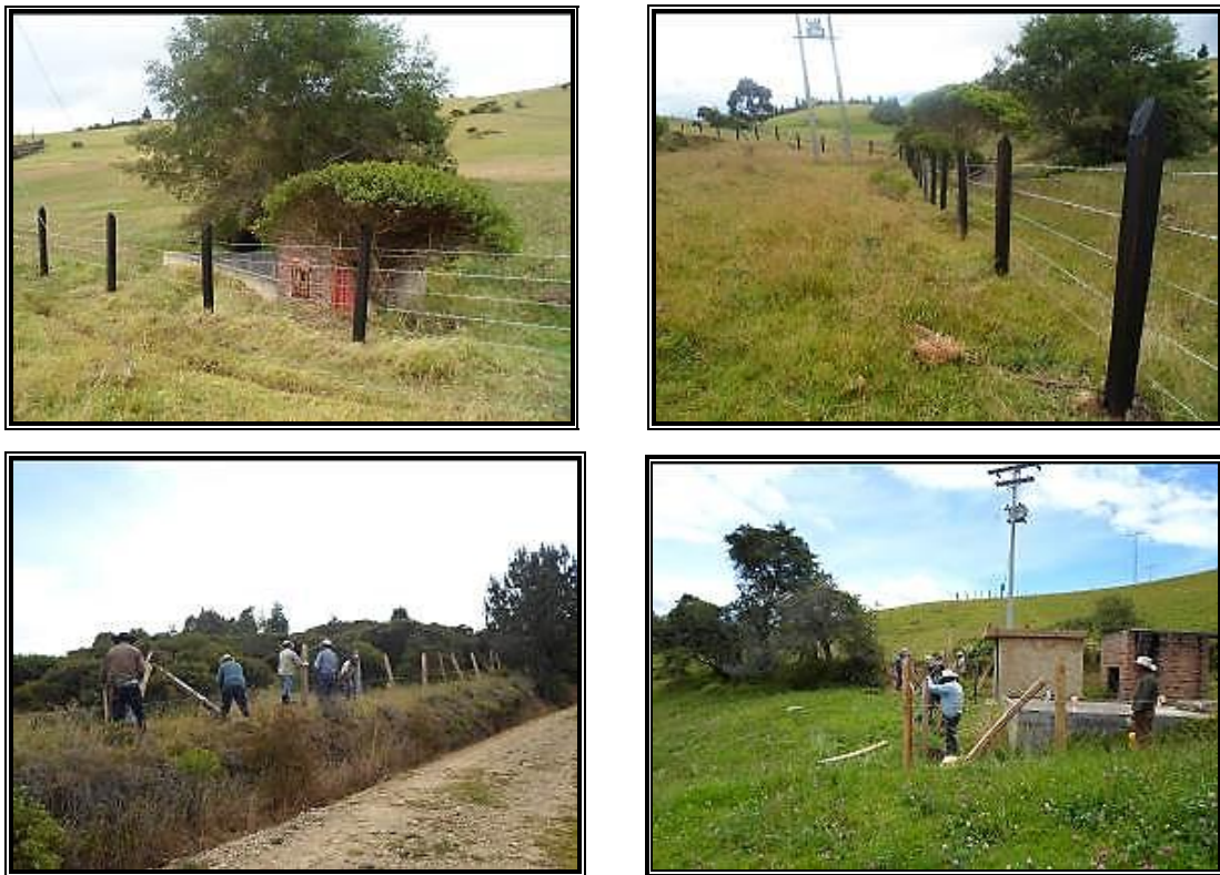
Figura 11. Proceso de cercado de los terrenos del acueducto.
