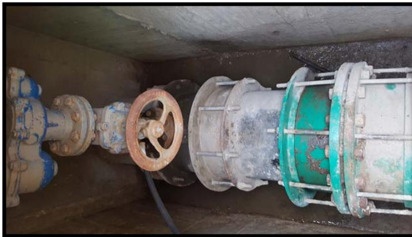
**Imagen 3.** *Conexión Fraudulenta dentro del sistema de Red de Acueducto*
