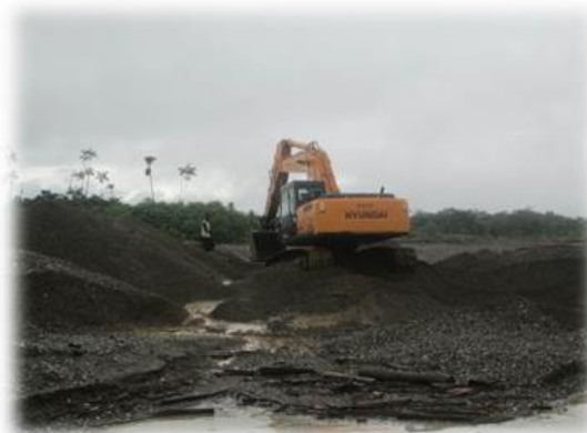
Figura 5: Retroexcavadoras utilizadas en el río Quito Fuente: Investigación Propia
