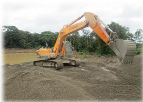
Figura 4: Retroexcavadoras utilizadas en el río Quito Fuente: Investigación Propia
