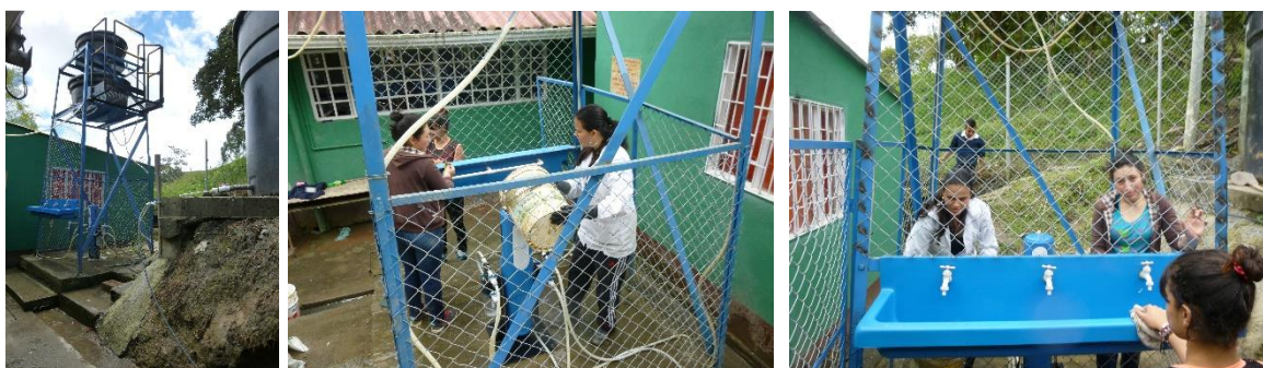
Imagen 21. Grupo de estudiantes que prestan su servicio social en el funcionamiento y mantenimiento de la planta de tratamiento de agua. Fuente Claudia Neusa (2015).
