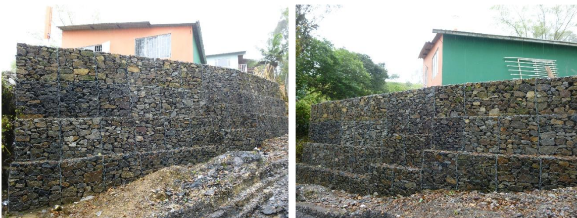
Imagen 20. Muro de contención construido para corregir la inestabilidad del terreno.
