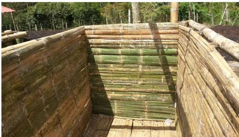
Figura 22. Interior de las fosas para los tratamientos de compostaje
