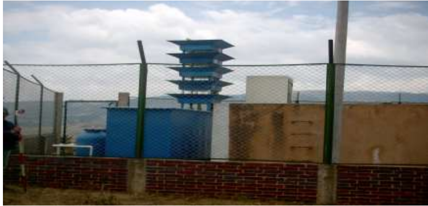
Foto: tanques de agua potable Oicatá
