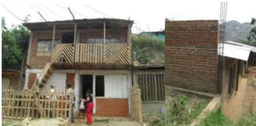
Sobre la estructura el 57% de las viviendas tienen sistema aporticado compuesta por columnas de concreto y muros de cerramiento de ladrillo farol además de vigas de cimentación corrida con mínimos refuerzos estructurales, la autoconstrucción y el empirismo sobre el tema
