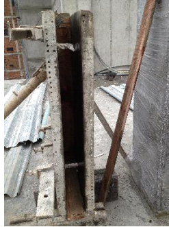
Figura 13. Formaleta y desmoldante
