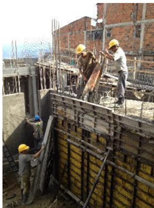
Figura 9. Proceso de vaciado de muros estructurales con formaleta metálica
