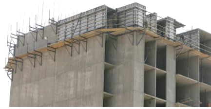
Figura 3. Sistema manportable para la construcción de viviendas multifamiliares de concreto.
