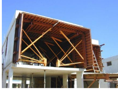
Figura 4. Sistema túnel para la construcción de estructuras de concreto.
