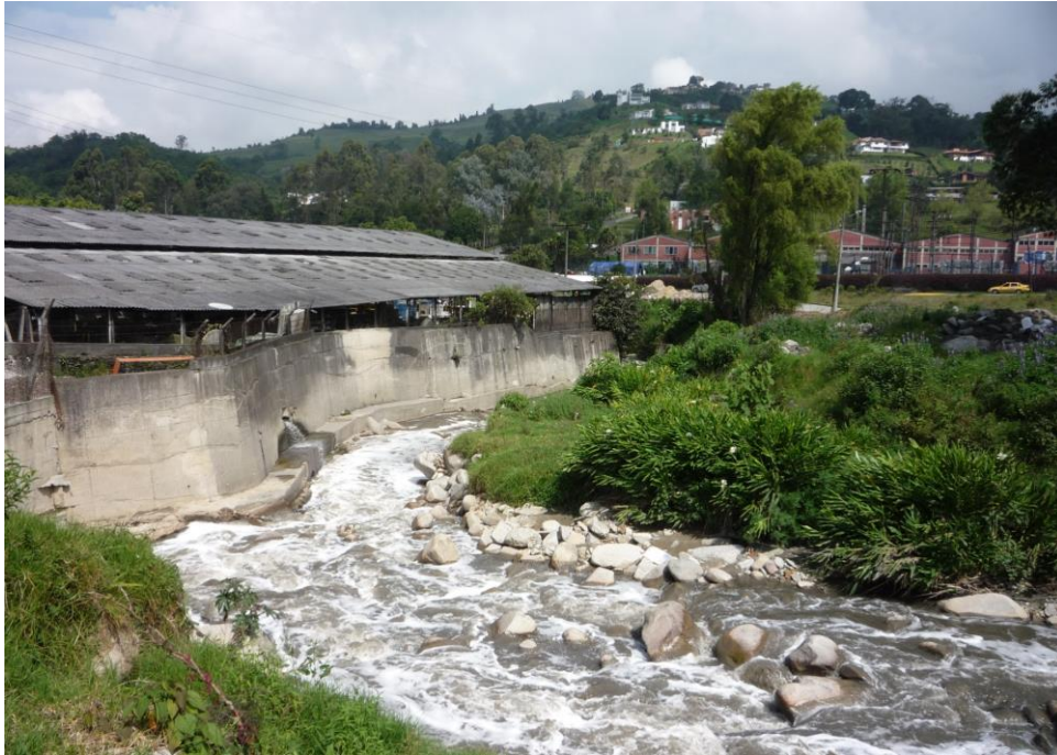
Construcciones industriales dentro del cauce de la Quebrada Manizales
