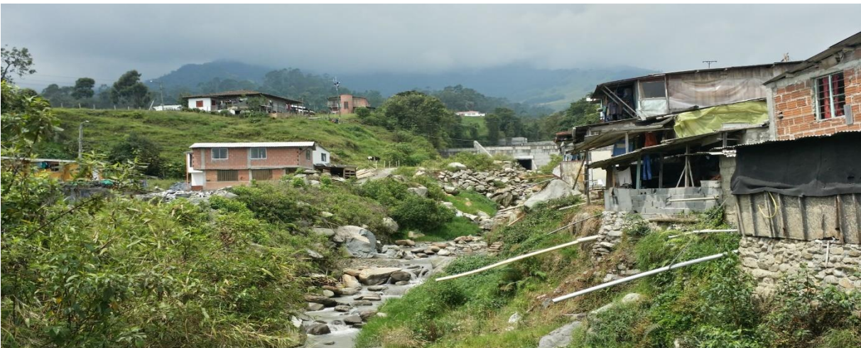
Ausencia de alcantarillado en el barrio Verdun , cuenca baja Quebrada Manizales
