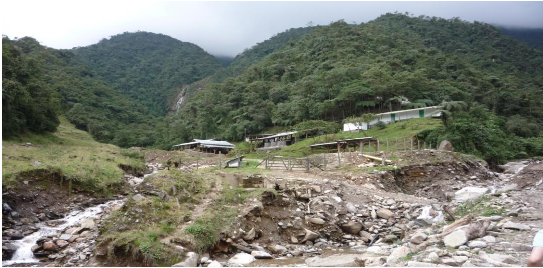
Socavación de orillas en la zona rural de la Quebrada Manizales
