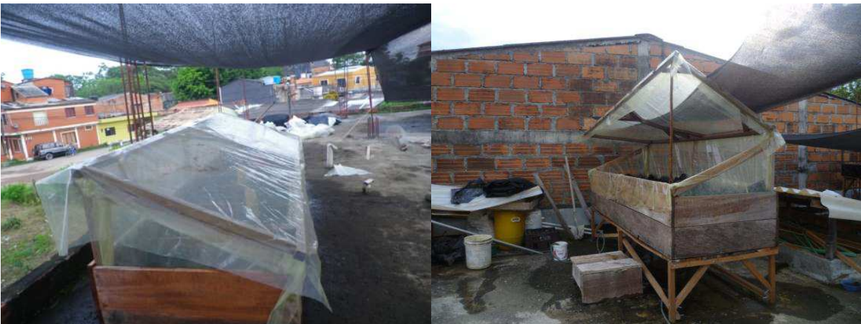
Figura 5-4: Izquierda: Propagador de sub-irrigación ubicado en el suelo de la terraza. Derecha: Propagador después de construirle la estructura para elevarlo y reducir humedad.
