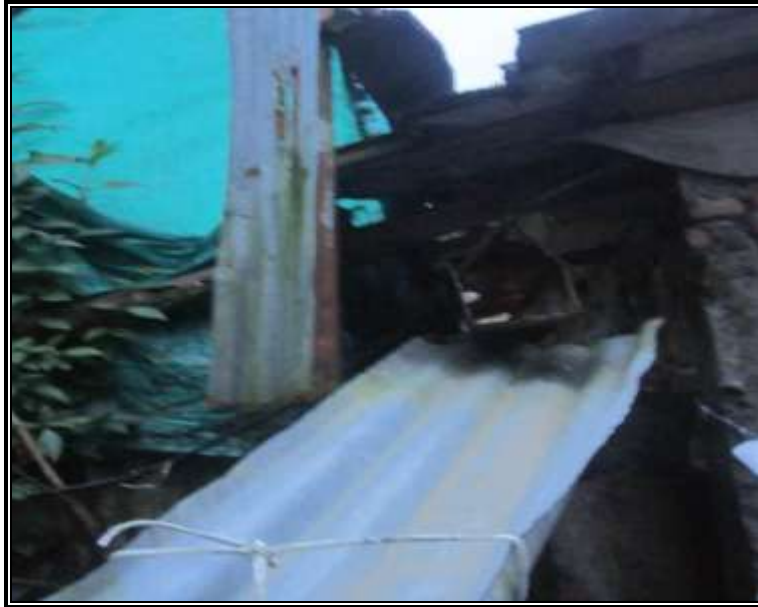
Figura 35. Canaletas en zinc para conducir el agua en las viviendas
