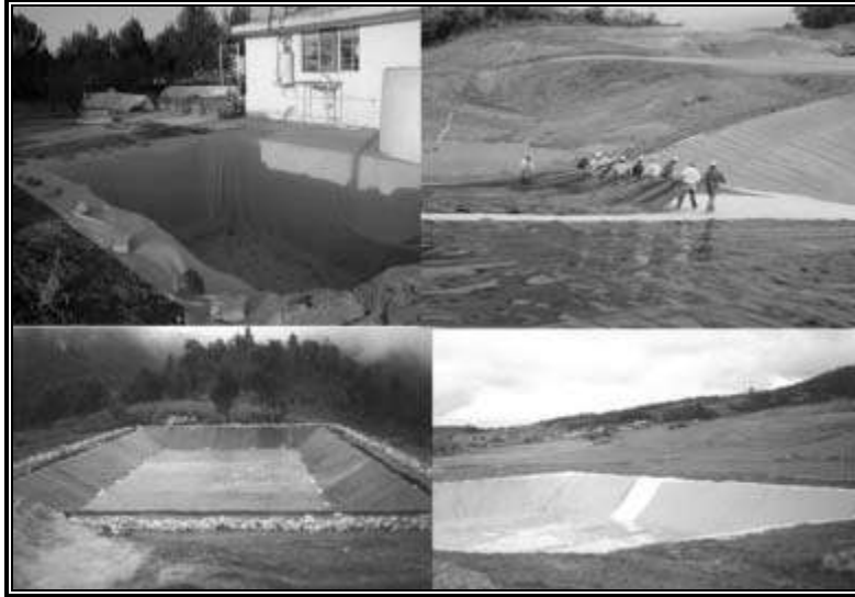
Figura 9. Cisternas revestidas con geomembrana y polietileno
