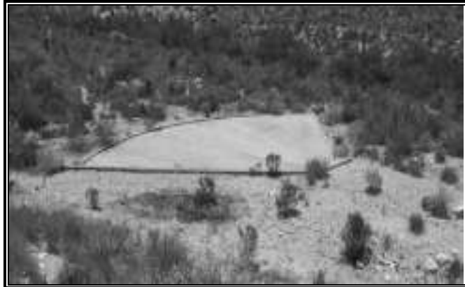
Figura 5. Ladera recubierta con concreto en forma de abanico
