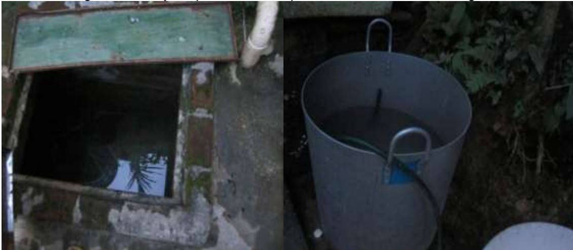
Figura 39. Pila y recipiente metálico para el almacenamiento del agua lluvia.
