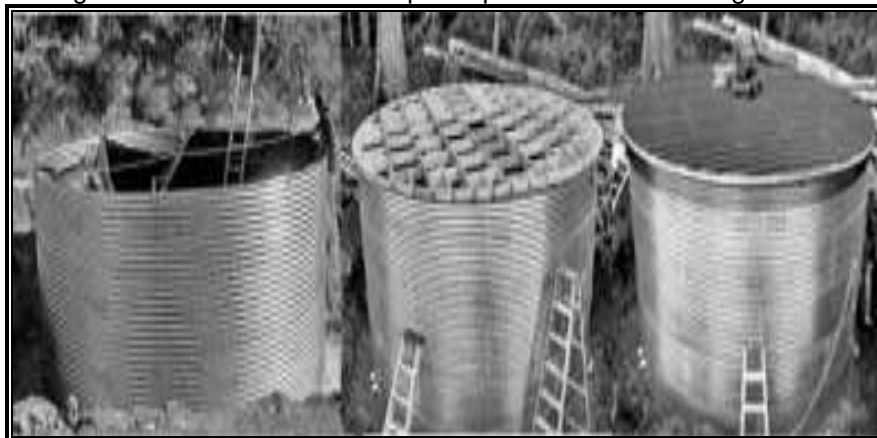
Figura 10. Cisternas de metal para aprovechamiento de agua lluvia
