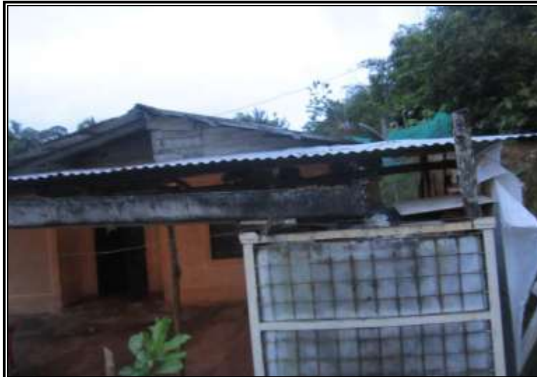
Figura 33. Techo en zinc utilizado en las viviendas
