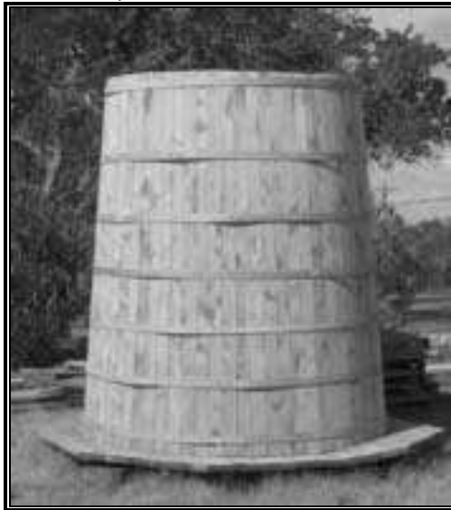
Figura 12. Cisterna de madera de pino con tensores para almacenar 5 m 3 .
