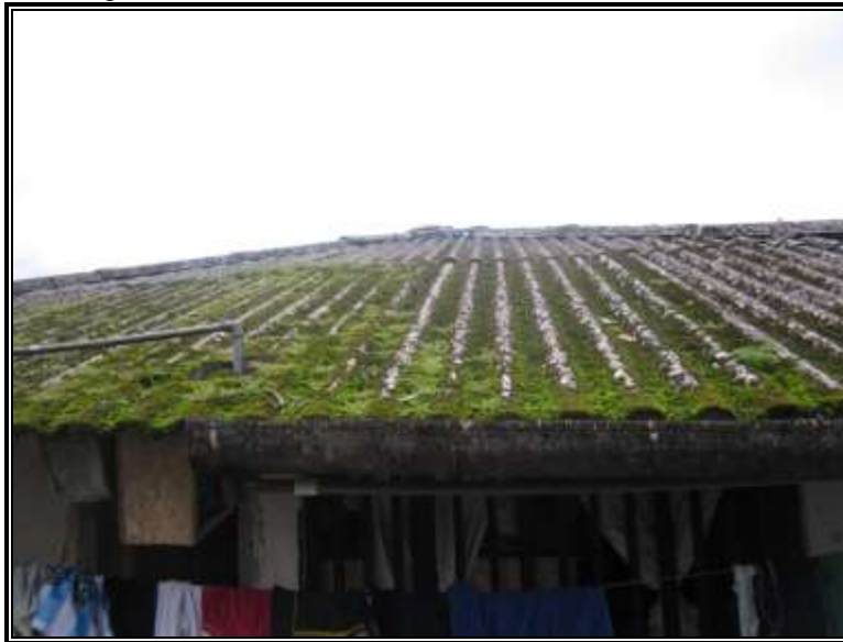
Figura 34. Techo en asbesto utilizado en las viviendas
