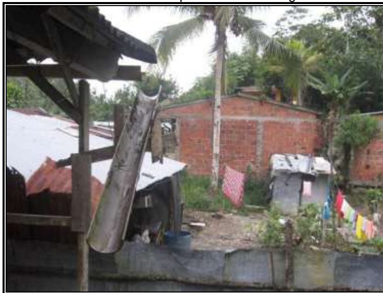
Figura 36. Canaletas en asbesto para conducir el agua en las viviendas
