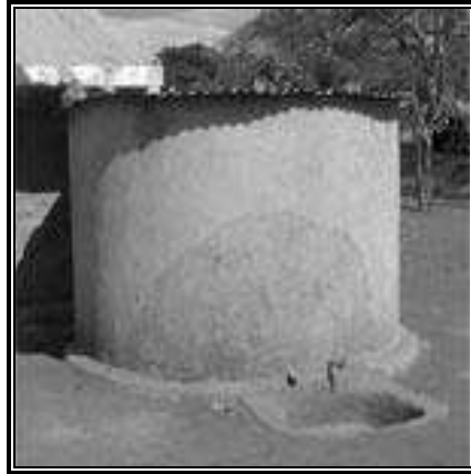
Figura 8. Tanques o cisternas de ferrocemento
