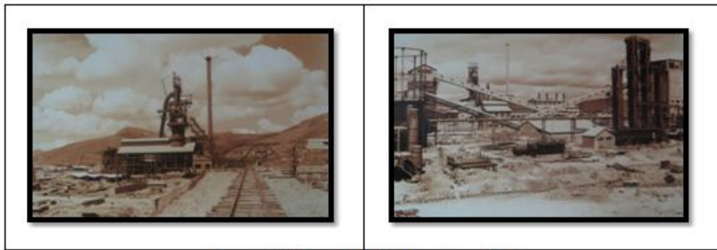
Figuras Nos. 2 y 3. Fotografías del montaje de la planta de APDR
