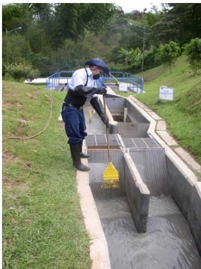
Figura 4-6: Limpieza Rejas de cribado
