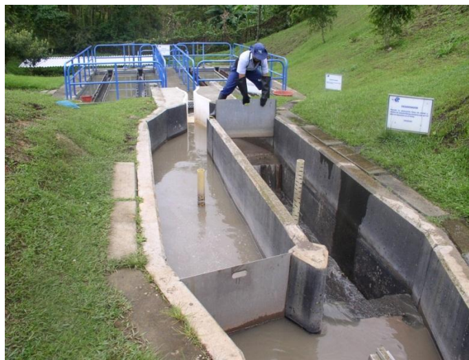
Figura 4-8: Compuertas para sacar de servicio un Desarenador
