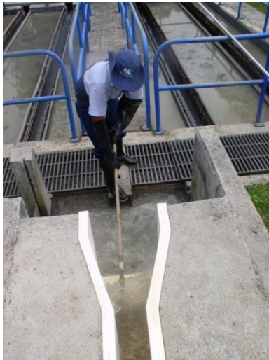
Figura 4-13: Limpieza Canaleta Parshall
