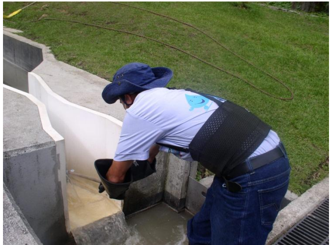
Figura 4-13: Limpieza Canaleta Parshall
