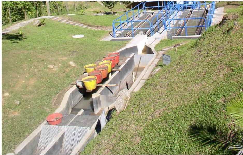
Figura 4-11: Esguimiento de lodo sacado de Desarenadores
