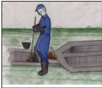
a) Limpieza de Rejillas
