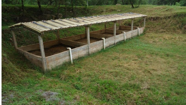
Figura 4-17: Lechos de secado
