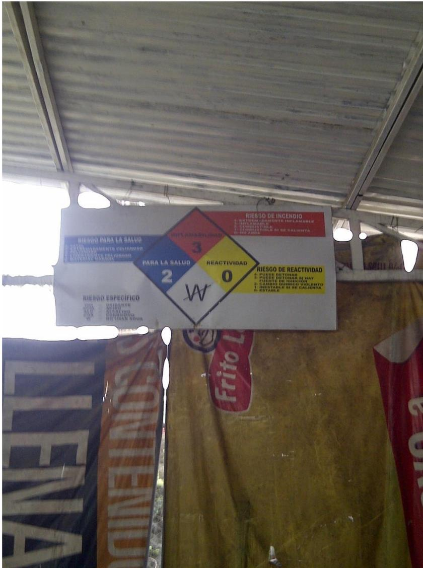
Imagen 2. Señalización con norma NFPA704 diamante de peligrosidad, en la zona de residuos peligrosos
