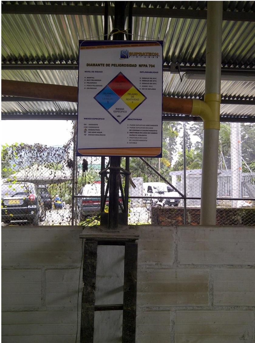
Imagen 3. Señalización con norma NFPA704 diamante de peligrosidad, en la zona de almacenamiento de sustancias peligrosas
