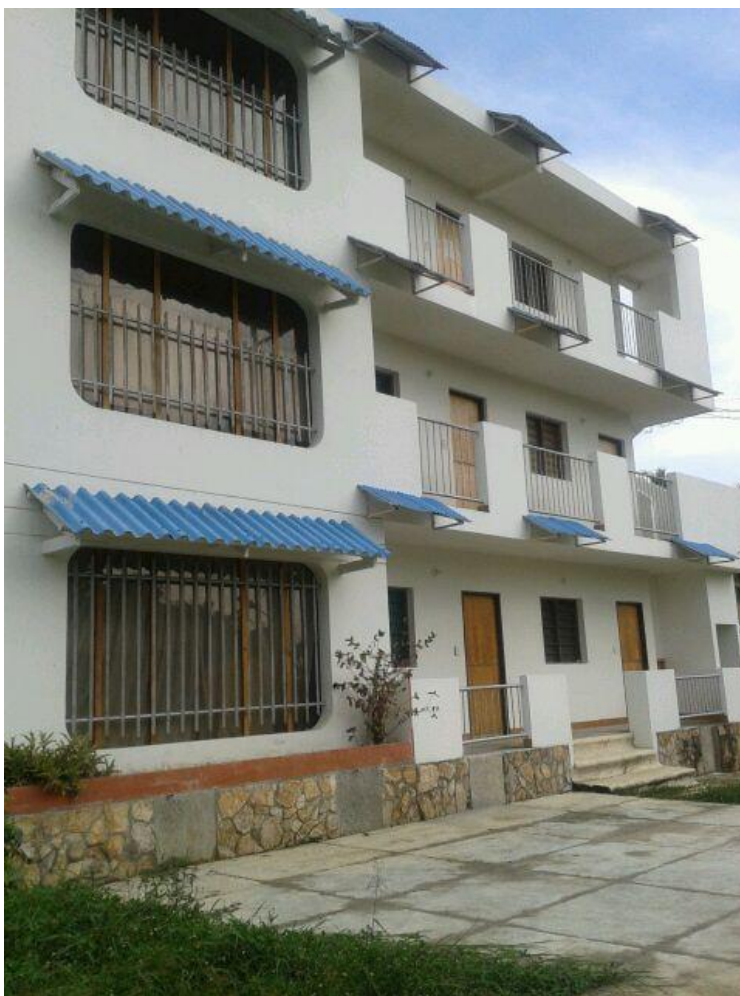
Imagen 18. Habitaciones del Centro Cultural Vacacional Fallegar
