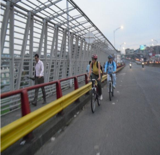
Foto N| 1 Ciclistas en el Viaducto Cesar Gaviria, Sentido Pereira-Ddas
