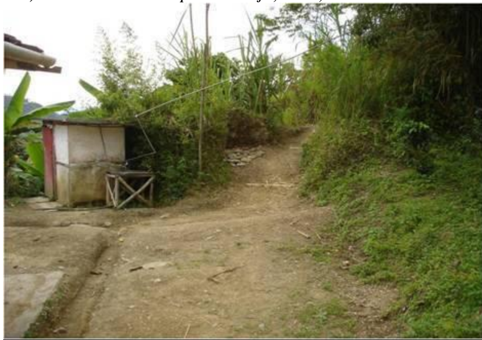
Figura 57. Camino de herradura con disipadores de aguas de escorrentía contruidos en guadua (agosto de 2008). Vereda Balmoral municipio de Filadelfia, Caldas, Colombia.
