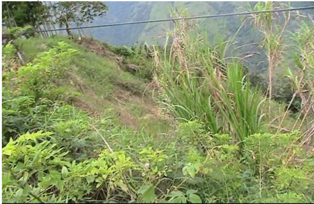
Figura 127. Restauración eficaz y efectiva, en 2 años y cuatro meses de realizadas las obras de bioingeniería agosto de 2010. Vía carreteable que conduce de Pácora a San Bartolomé. Municipio de Pácora Vereda San Bartolomé, sector El Escobal.
