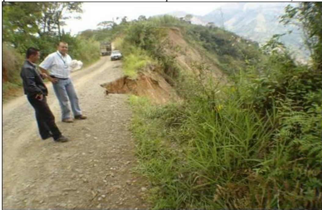
Figura 89. Recorrido exploratorio por la parte baja de la banca de la carretera vía San Bartolomé, sector El Escobal, municipio de Pácora Caldas. Se observa la longitud del escarpe mayor de 2000 m, la inclinación de la ladera con pendiente mayor del 100%. Septiembre de 2008. Vía carreteable que conduce de Pácora a San Bartolomé. Municipio de Pácora Vereda San Bartolomé, sector El Escobal.
