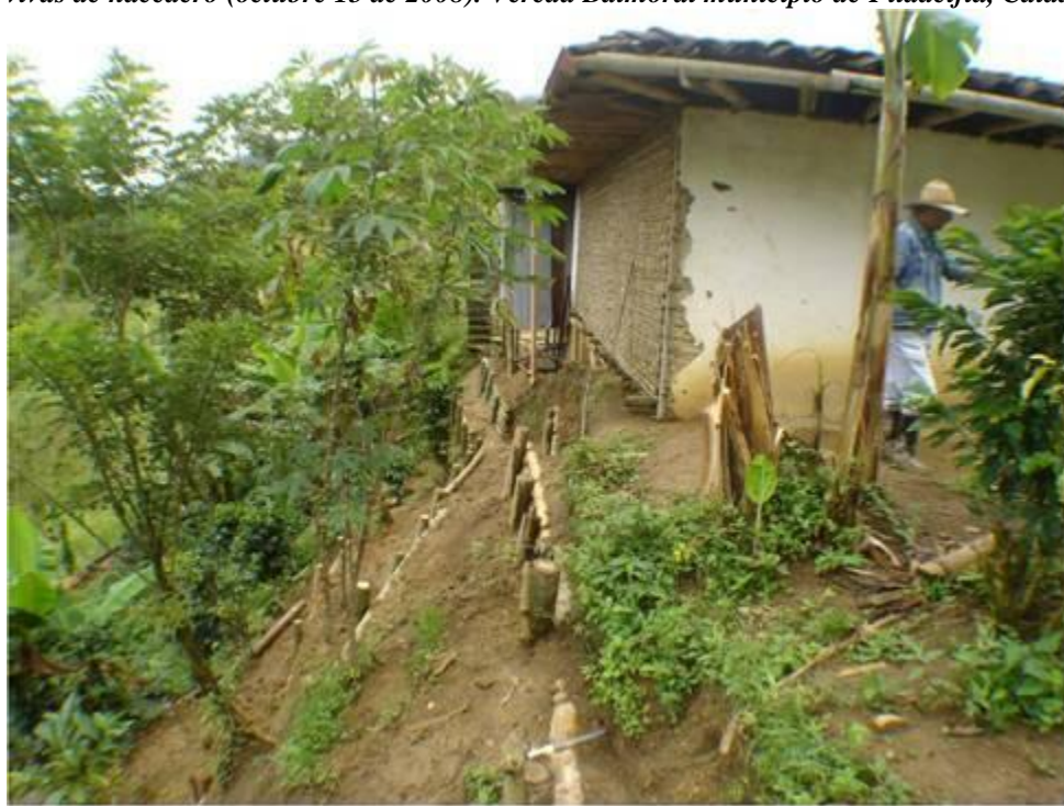
Figura 63. Estabilización de los cimientos de la vivienda con trinchos vivos en guadua reforzados con estacas vivas de nacedero (octubre 15 de 2008). Vereda Balmoral municipio de Filadelfia, Caldas, Colombia.
