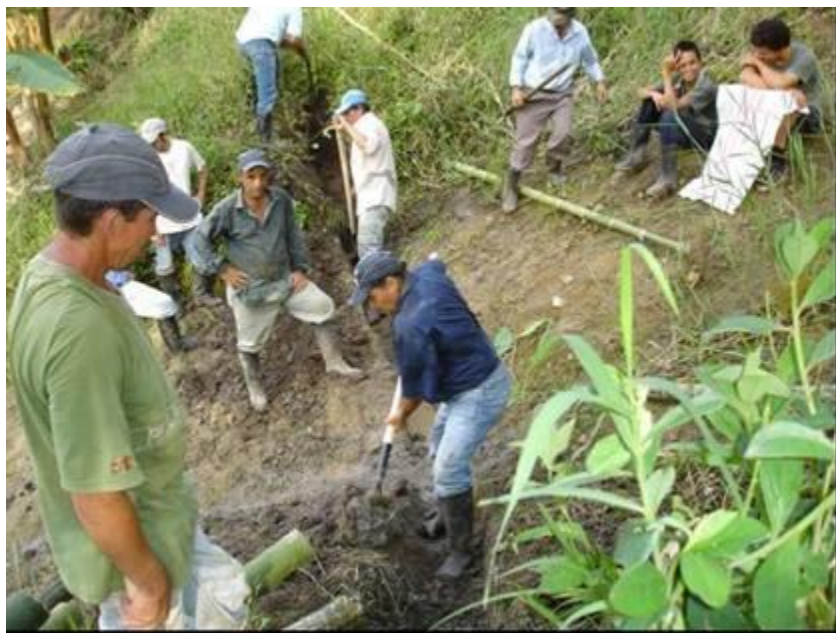
Figura 16. Capacitación en campo de la comunidad afectada de la Vereda río claro, municipio de Villamaría, Caldas Colombia. Orientaciones sobre cómo construir un buen trincho para la conducción de aguas de escorrentía. Julio 1 de 2008.
