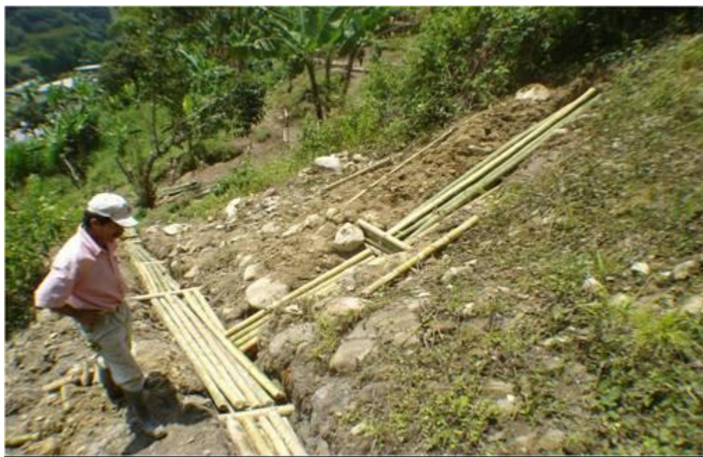
Figura 26. Sistema de drenaje con filtros vivos en espina de pescado para la evacuación de aguas subsuperficiales. Octubre de 2008. Vereda Río Claro viejo municipio de Villamaría, Caldas, Colombia.
