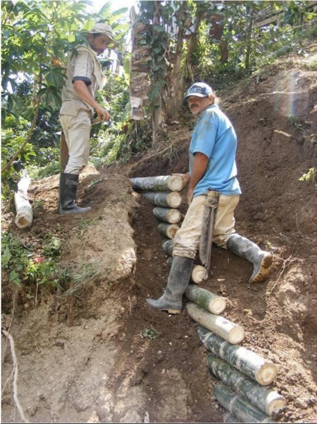
Figura 66. Forma de empotrar uno de los trinchos (agosto de 2008). Vereda Balmoral municipio de Filadelfia, Caldas, Colombia.
