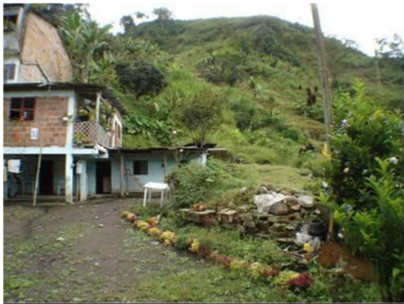
Figura 6. Los techos de la vivienda no presentan canaletas recolectoras de aguas de escorrentía, ni bajantes, absorbiendo el terreno toda el agua. Vereda Rio Claro viejo, Villamaría, Caldas. Julio de 2008.
