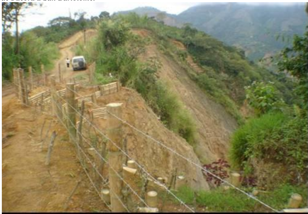
Figura 101. Aislamiento del área estabilizada, y siembra de estacas de matarratón. Vía carretable que conduce de Pácora a San Bartolomé.
