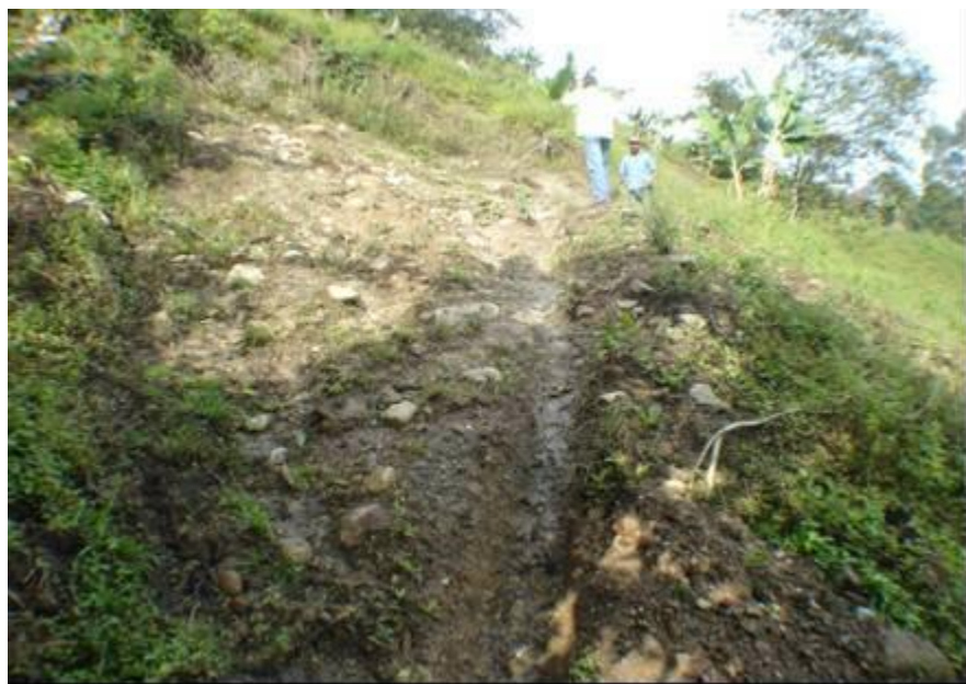
Figura 21. Zona de anegamiento Vereda Río Claro Villamaría. Se observa una acequia de ladera muy superficial que no cumple función alguna, sitio donde se construyó un sistema de filtros vivos en espina de pescado (figura 25). Marzo de 2008.
