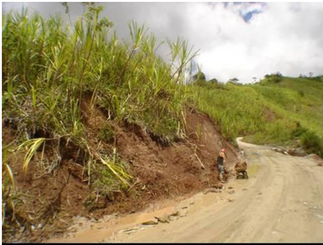
Figura 30. Uso del suelo en caña panelera. Se observa procesos erosivos y de movimiento en masa. Vía Neira a Filadelfia Caldas, Colombia.
