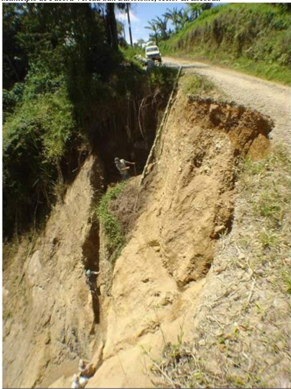
Figura 98. Sector 1. Iniciación de trabajos de bioingeniería en el sitio por donde se concentran las aguas de escorrentía provenientes de la vía. Se comenzaron los trabajos de disipación de energía, mediante la construcción de trinchos vivos escalonados. Septiembre de 2008. Vía carreteable que conduce de Pácora a san Bartolomé. Municipio de Pácora Vereda San Bartolomé, sector El Escobal.
