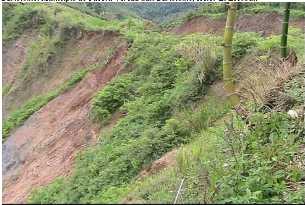
Figura 125. Estado de restauración de los taludes de la banca en 1,5 años de construidas las obras, lo que indica que las obras han sido eficaces y efectivas. Agosto de 2010. Vía carreteable que conduce de Pácora a San Bartolomé. Municipio de Pácora Vereda San Bartolomé, sector El Escobal.
