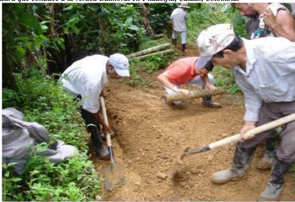
Figura 53. Construcción de ventanas para evacuación de caudales pequeños de aguas de escorrentía del camino de herradura que conduce a la vereda Balmoral en Filadelfia, Caldas, Colombia.
