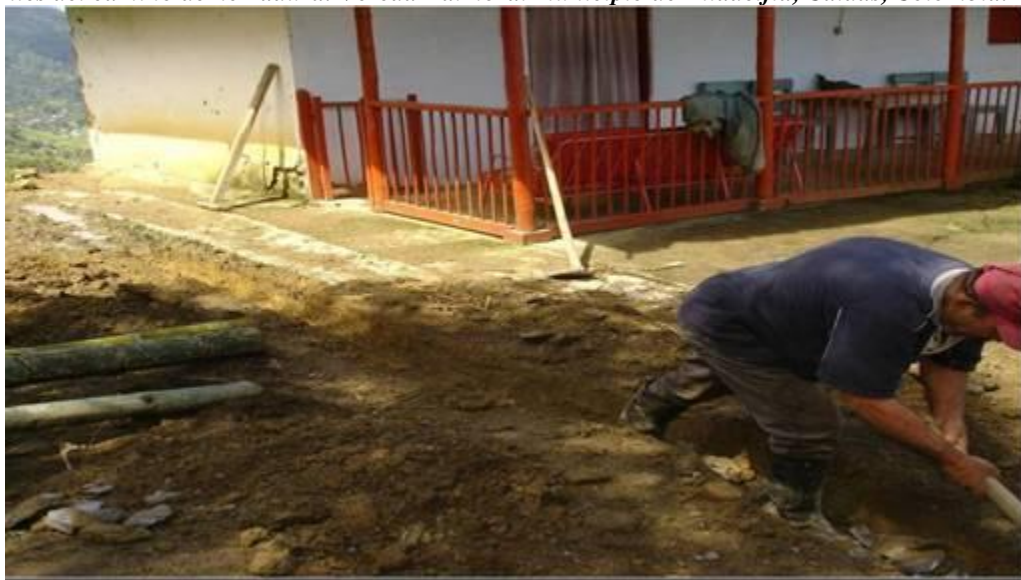
Figura 56. Canal con pendiente contraria al talud inestable, para evita la entrada de las aguas de escorrentía provenientes del camino de herradura. Vereda Balmoral municipio de Filadelfia, Caldas, Colombia.
