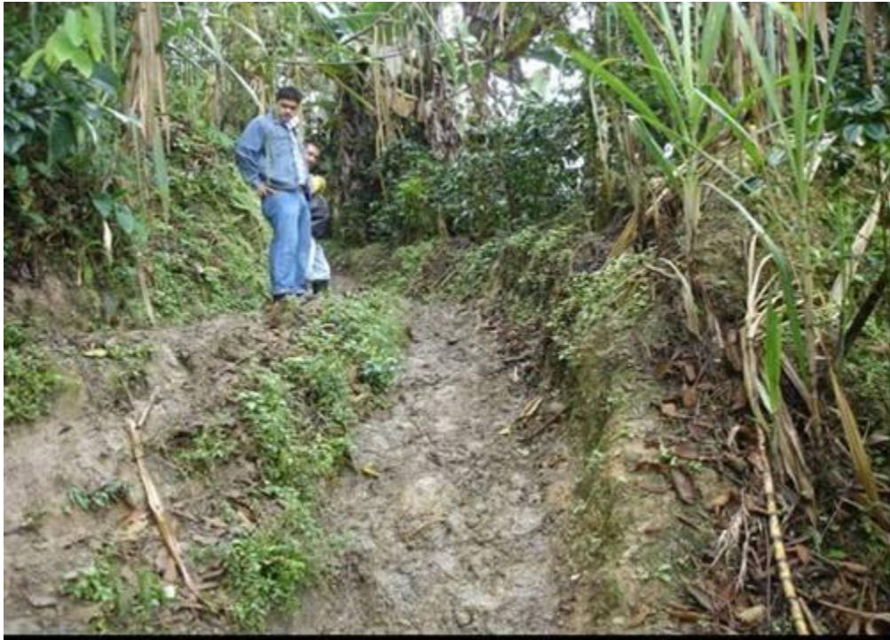
Figura 43. Paso anegado y difícil para los peatones en el camino que conduce a la Vereda Balmoral, municipio de Filadelfia Caldas, Colombia.
