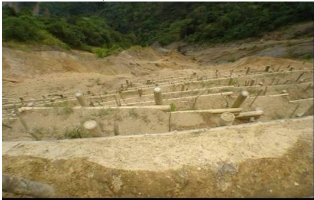
Figura 119. Construcción de trinchos vivos escalonados, reforzados con siembra de estacas vivas de matarratón para estabilizar talud bajo de la vía que conduce del corregimiento San Bartolomé sector El Escobal al municipio de Pácora, Caldas. Febrero de 2009. Vía carreteable que conduce de Pácora a San Bartolomé. Municipio de Pácora Vereda San Bartolomé, sector El Escobal.
