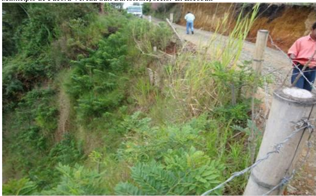
Figura 105. Sector 1. Avances en la estabilización y restitución de parte de la banca de carretera, mediante la construcción de trinchos vivos escalonados. Corregimiento de San Bartolomé, sector El Escobal, municipio de Pácora, Caldas. Se observa el cambio y el crecimiento de la vegetación en 11 meses. Noviembre de 2009. Municipio de Pácora Vereda San Bartolomé, sector El Escobal.
