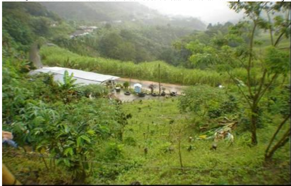
Figura 77. Cubrimiento del talud con coberturas vegetales en un mes aproximadamente, como prueba de la estabilización del terreo. Noviembre 23 de 2008. Vereda Balmoral municipio de Filadelfia, Caldas, Colombia.
