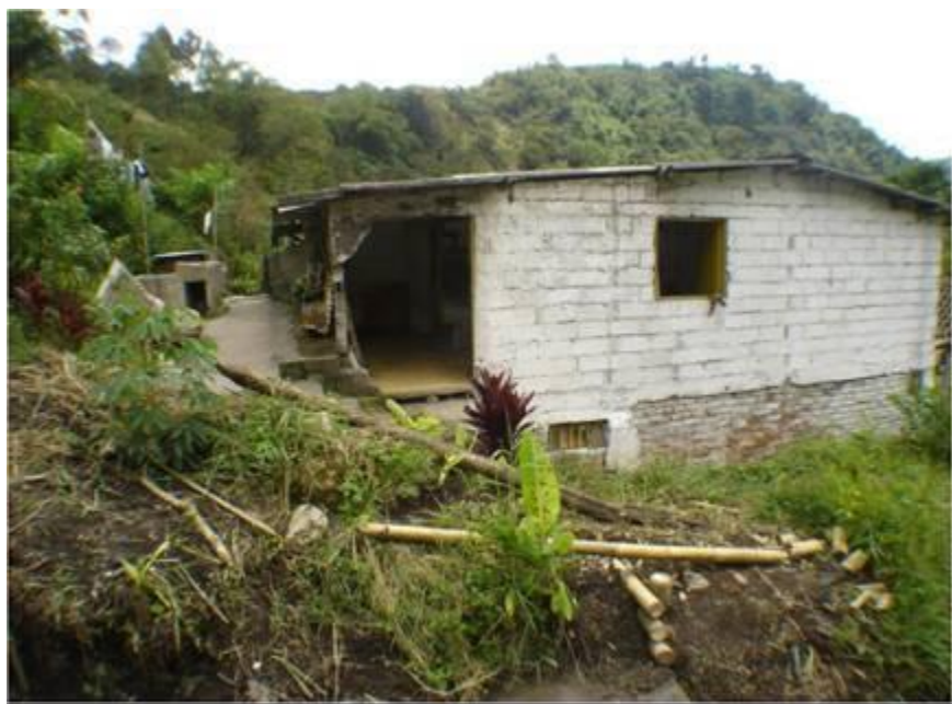
Figura 11. Estado de una de las viviendas, luego de los deslaves ocurridos en la zona (marzo de 2008).
