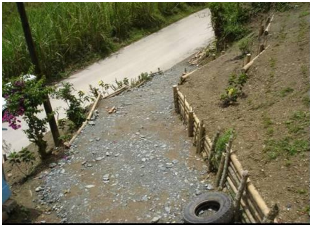
Figura 76. Entrada a la casa, luego de estabilizado y restaurado el terreno (marzo 10 de 2008). Vereda Balmoral municipio de Filadelfia, Caldas, Colombia.
