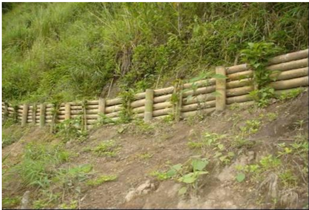
Figura 28. Trincho vivo visto de cerca. Se observa el rebrote de las estacas de nacedero trichanthera gigantea. Noviembre de 2008. Vereda río claro viejo municipio de Villamaría, Caldas, Colombia.
