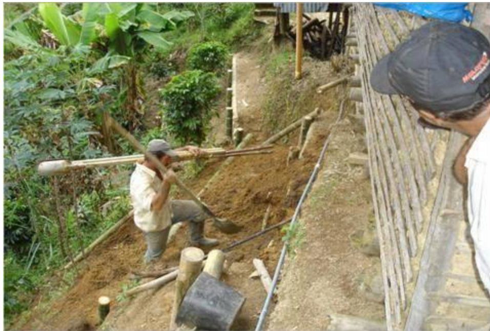
Figura 62. Construcción de trinchos vivos escalonados en guadua, para estabilizar los cimientos de la vivienda, que presentaba riesgo alto al colapso (agosto de 2008). Vereda Balmoral municipio de Filadelfia Caldas, Colombia.
