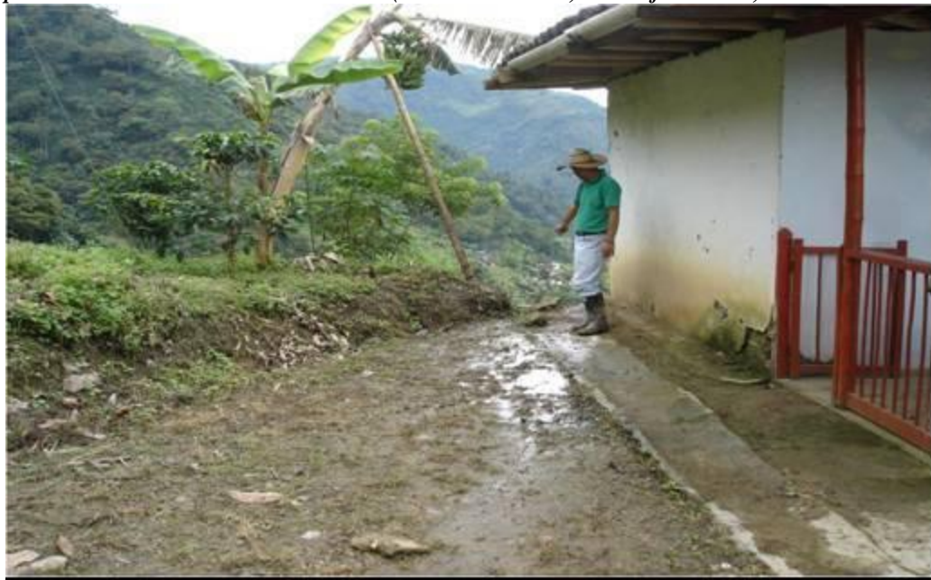
Figura 44 Sitio donde confluyen las aguas de escorrentía provenientes del camino de herradura y del techo de la vivienda. Aguas que penetran a la ladera con reptación, ayudando al proceso de saturación del terreno y al proceso activo de movimiento en masa (Vereda Balmoral, Filadelfia Caldas, Colombia. Julio 20 de 2008).
