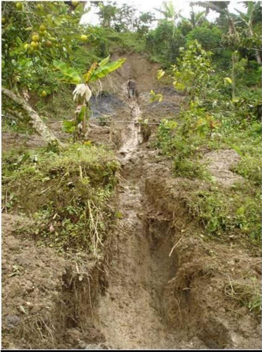
Figura 60. Se construyeron trinchos vivos en guadua escalonados tanto desde la parte trasera de la casa en el talud alto, para su estabilización (figura), y como para el acompañamiento de filtros vivos en guadua construidos a cada 4 m de distancia entre ellos ladera abajo hasta llegar a la carretera principal (julio). Vereda Balmoral municipio de Filadelfia, Caldas, Colombia.
