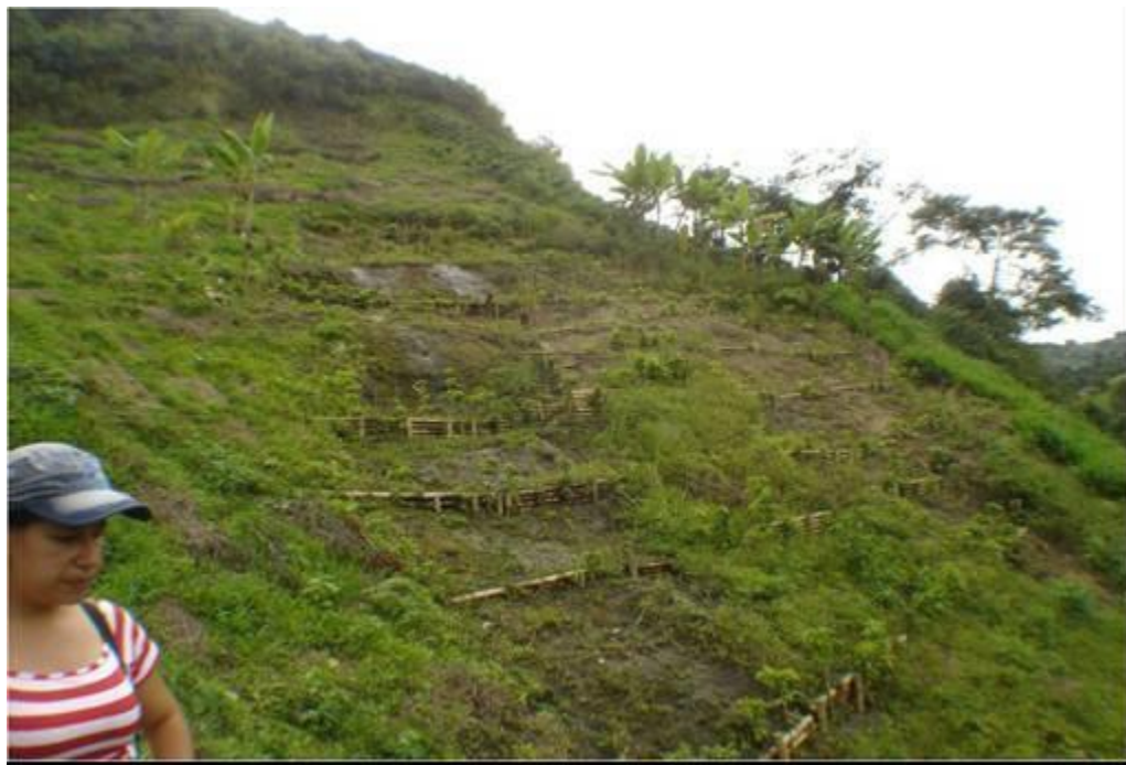
Figura 27. Trinchos vivos escalonados. Se observa el rebrote de las estacas de nacedero trichanthera gigantea. Noviembre de 2008. Vereda río claro viejo municipio de Villamaría, Caldas, Colombia.
