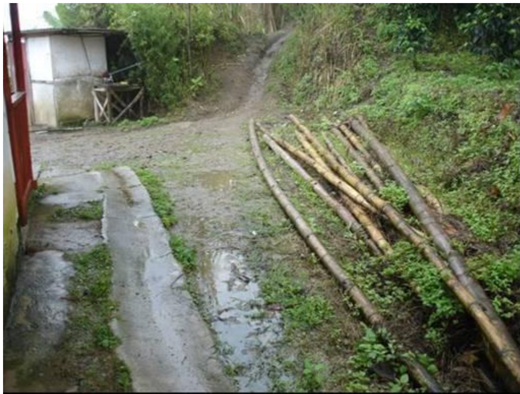
Figura 33. Sitio donde confluyen y se acumulan las aguas de escorrentía provenientes del techo de la vivienda y del camino de la servidumbre de la Vereda Balmoral, municipio de Filadelfia, Caldas, Colombia.
