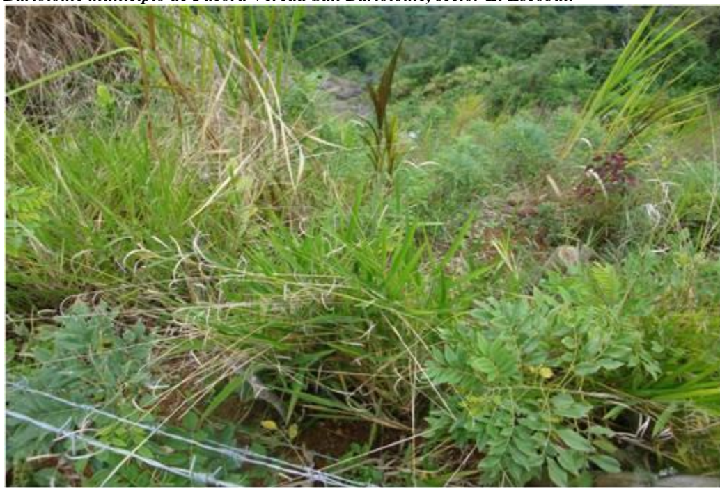
Figura 109. Sector 2. Se aprecia el rebrote de estacas vivas de matarratón, lechero y el cubrimiento del terreno con gramíneas como un indicador de estabilización del proceso degradativo. El 100% del sector presenta cobertura vegetal, demostrando la efectividad de las obras de bioingeniería. Corregimiento San Bartolomé sector El Escobal municipio de Pácora, Caldas noviembre de 2009. Vía carreteable que conduce de Pácora a San Bartolomé municipio de Pácora Vereda San Bartolomé, sector El Escobal.
