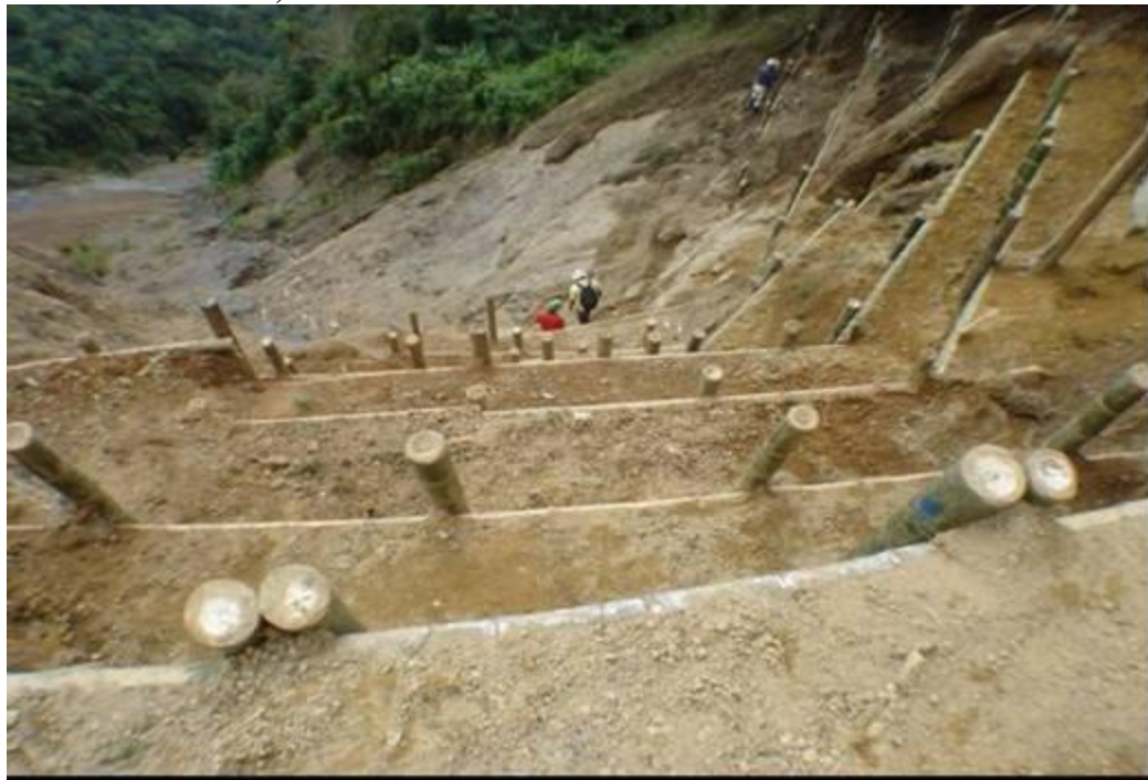
Figura 103. Trinchos en guadua construidos de arriba hacia abajo. Se observa lo abrupto de la pendiente, mayor del 100%. Diciembre de 2008. Vía carreteable que conduce de Pácora a San Bartolomé. Municipio de Pácora Vereda san Bartolomé, Sector el Escobal.
