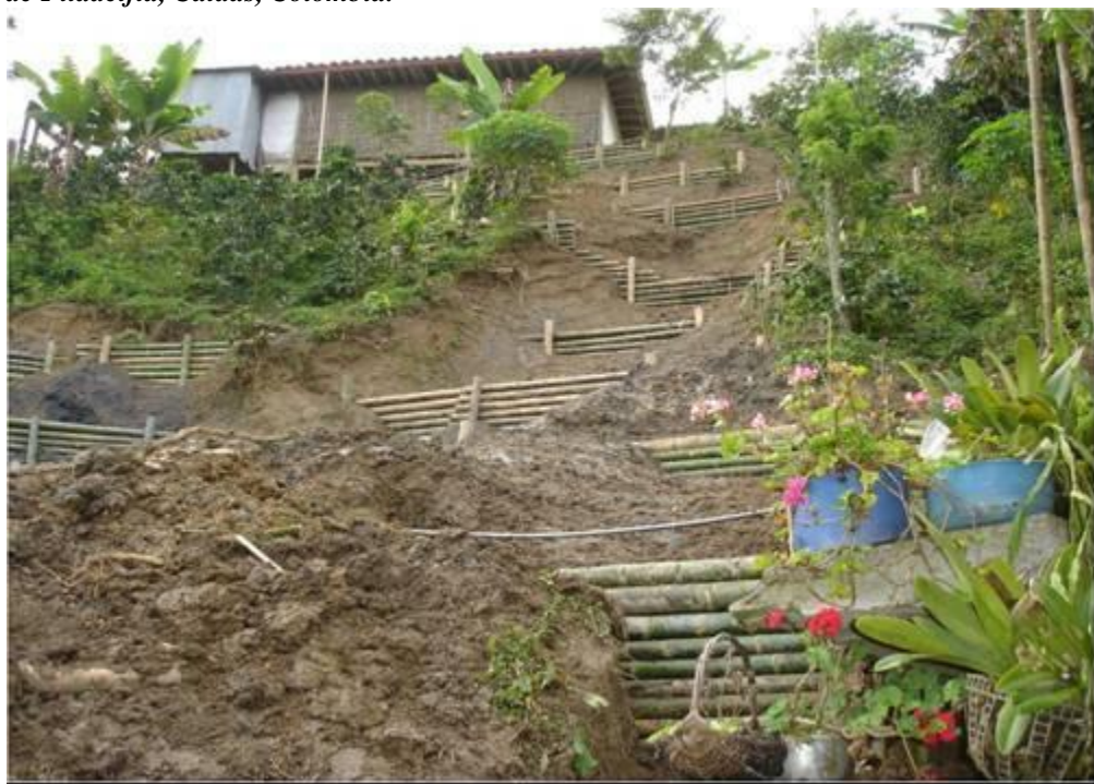
Figura 71. Compactación manual del terreno y perfilado del talud (agosto de 2008). Vereda Balmoral municipio de Filadelfia, Caldas, Colombia.
