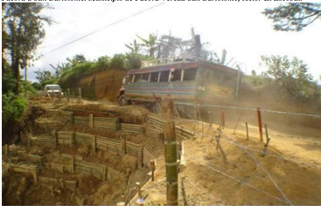
Figura 104. Sector 1. Avances en la estabilización y restitución de parte de la banca de carretera, mediante la construcción de trinchos vivos escalonados, dando vía a los primeros vehículos. Corregimiento de San Bartolomé, sector El Escobal, municipio de Pácora, Caldas. Diciembre de 2008. Vía carreteable que conduce de Pácora a San Bartolomé. Municipio de Pácora Vereda San Bartolomé, sector El Escobal.
