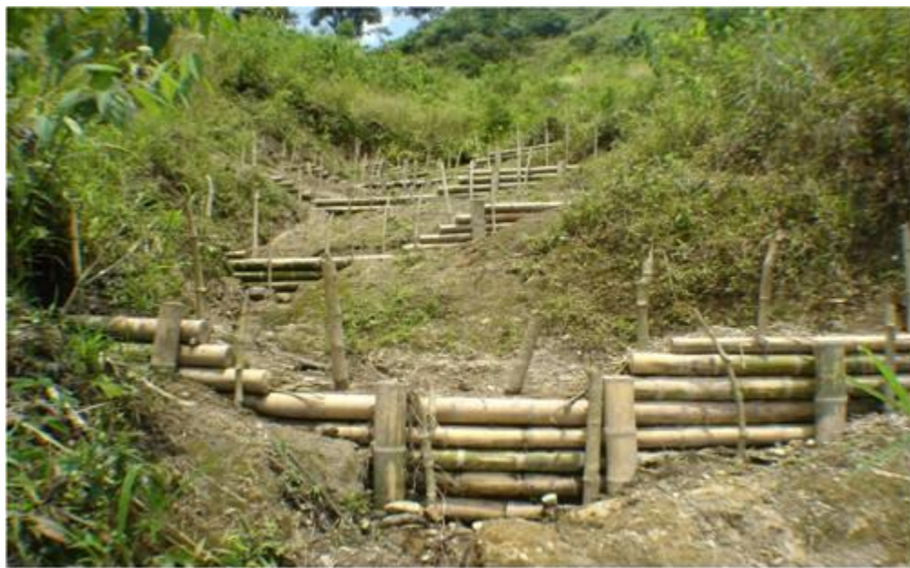
Figura 26. Sistema de drenaje con filtros vivos en espina de pescado para la evacuación de aguas subsuperficiales. Octubre de 2008. Vereda Río Claro viejo municipio de Villamaría, Caldas, Colombia.
