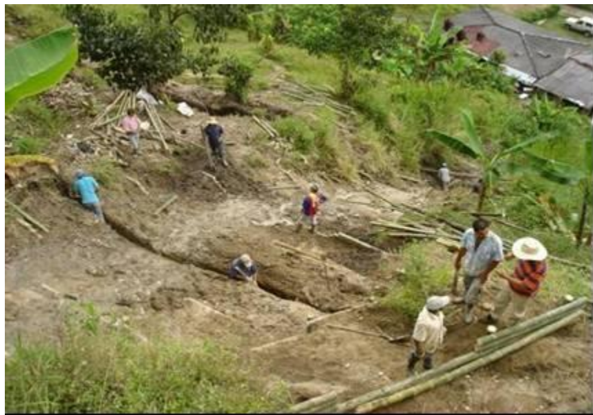
Figura 17. Trazado de zanjas atravesando el cauce de la quebrada, con el fin de colocar trinchos anclados en los taludes estables del drenaje natural.
