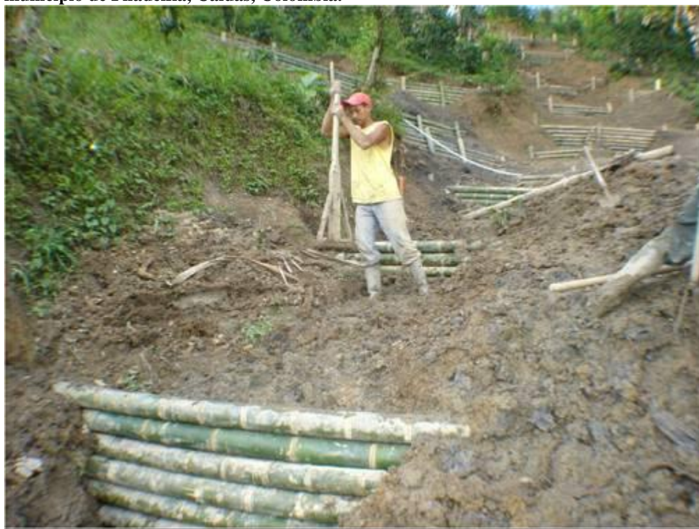
Figura 71. Compactación manual del terreno y perfilado del talud (agosto de 2008). Vereda Balmoral municipio de Filadelfia, Caldas, Colombia.
