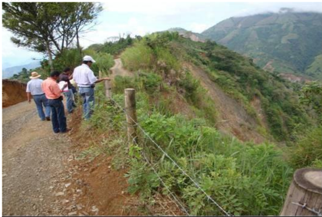
Figura 110. Se observa el proceso de establecimiento de la vegetación sembrada como complemento de las obras de bioingeniería, las cuales actúan como refuerzo mecánico para el talud, al aumentarse su cohesión. Vegetación que fue posteriormente quitada para el establecimiento de un muro de concreto. Noviembre de 2009. Vía carreteable que conduce de Pácora a San Bartolomé. Municipio de Pácora Vereda San Bartolomé, sector El Escobal.
