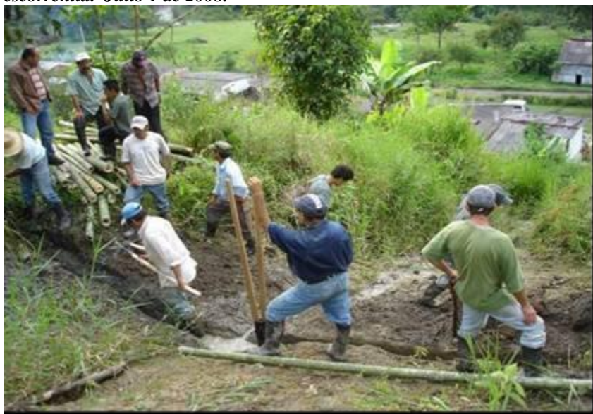
Figura 16. Capacitación en campo de la comunidad afectada de la Vereda río claro, municipio de Villamaría, Caldas Colombia. Orientaciones sobre cómo construir un buen trincho para la conducción de aguas de escorrentía. Julio 1 de 2008.
