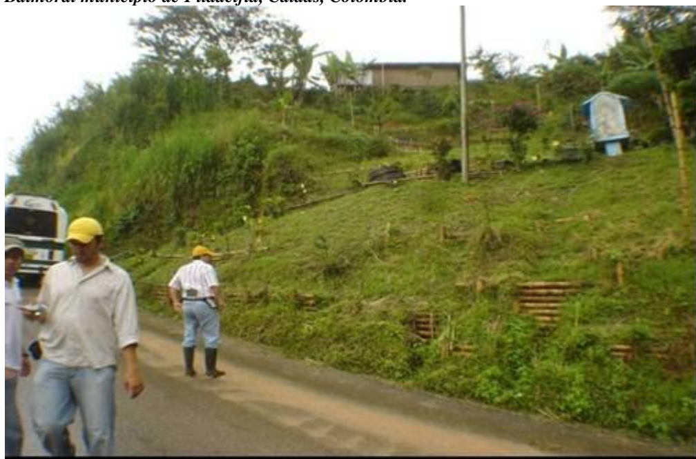
Figura 78. Restauración cubrimiento por coberturas vegetales del área afectada. Noviembre 23 de 2008. Vereda Balmoral municipio de Filadelfia, Caldas, Colombia.
