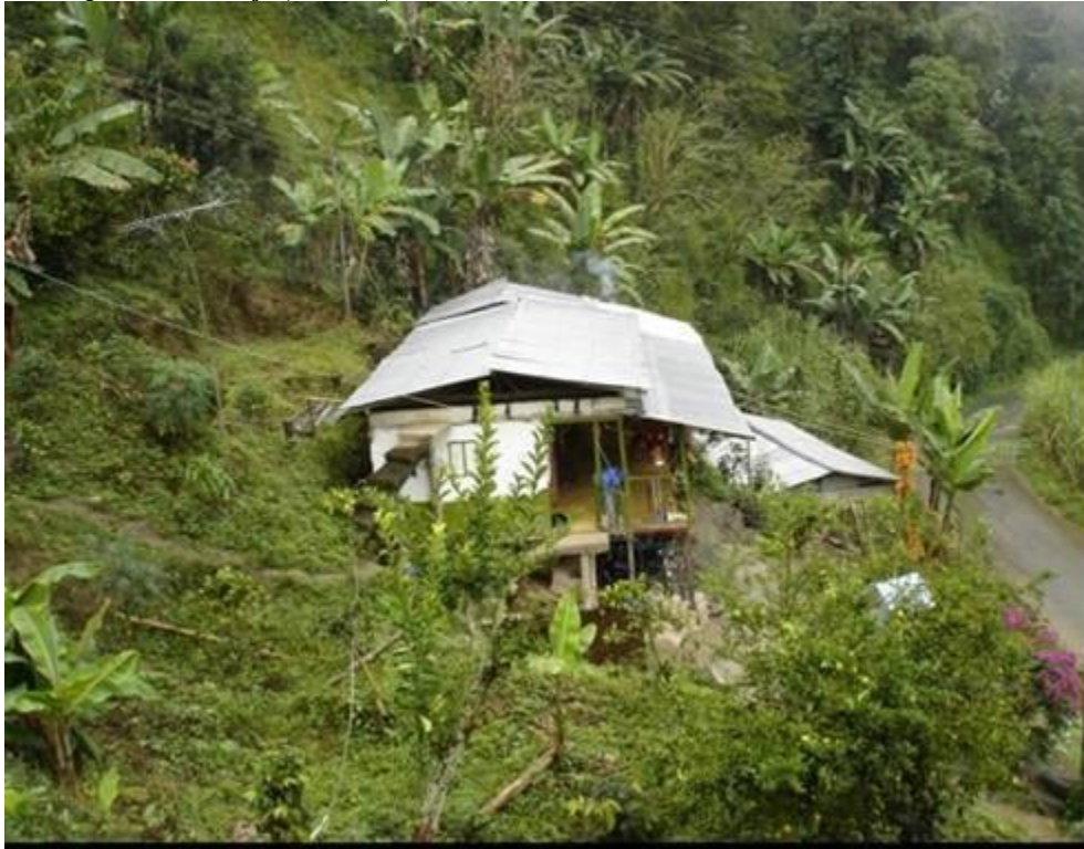
Figura 48. Talud con problema de reptación. Desaparecieron dos habitaciones de concreto. Vereda Balmoral municipio de Filadelfia, Caldas, Colombia.
