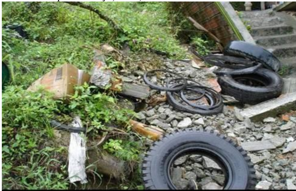
Figura 51. Presencia de escombros producto de la destrucción de dos habitaciones de la vivienda. Vereda Balmoral municipio de Filadelfia, Caldas, Colombia.
