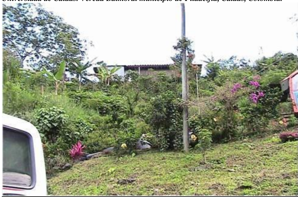
Figura 80. Estado de la estabilización del terreno luego de los tratamientos con bioingeniería, luego de 2 años aproximadamente de entregadas las obras, como una muestra de la efectividad de las obras de bioingeniería (agosto de 2010). Imagen facilitada por Fernando Sánchez Zapata ingeniero geólogo, especialista, docente Universidad de Caldas. Vereda Balmoral municipio de Filadelfia, Caldas, Colombia.
