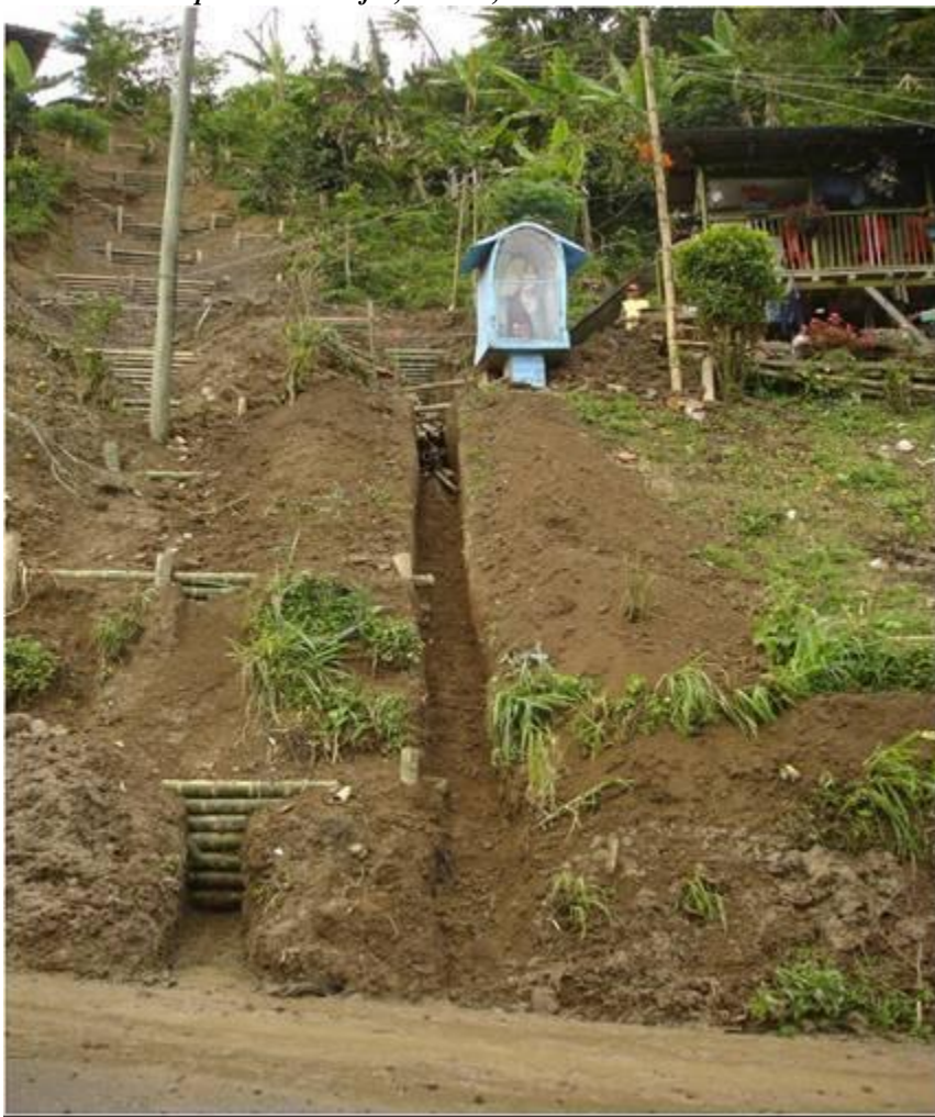
Figura 61. Construcción de obras de estabilización con trinchos vivos escalonados y filtros vivos. Agosto de 2008. Vereda Balmoral municipio de Filadelfia, Caldas, Colombia.
