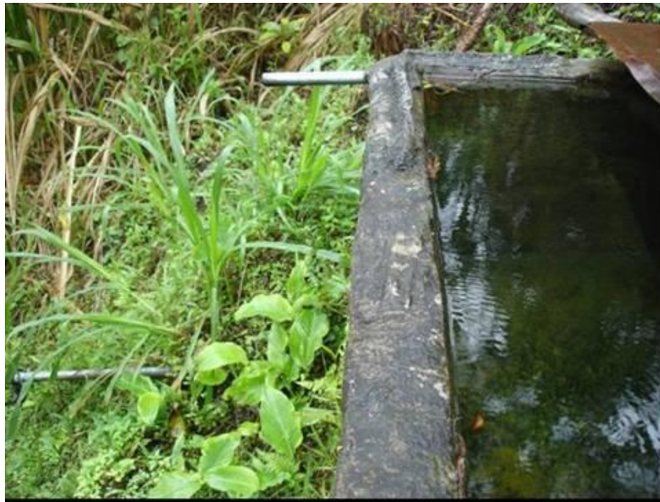
Figura 40. Tanque de almacenamiento de agua, cuyo rebose vierte directamente al talud escarpado pudiendo ocasionar un deslizamiento por saturación del terreno. Vereda Balmoral Municipio de Filadelfia, Caldas, Colombia.
