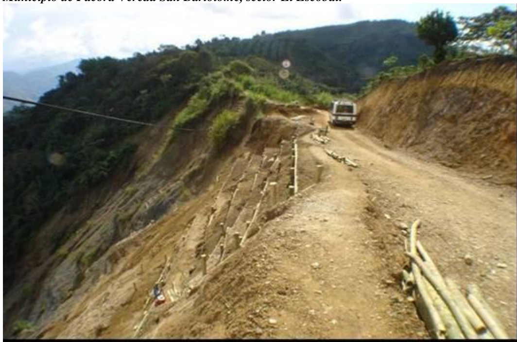
Figura 118. Construcción de trinchos vivos escalonados para estabilizar talud bajo de la vía que conduce del corregimiento San Bartolomé sector El Escobal al municipio de Pácora, Caldas. Diciembre de 2008. Vía carreteable que conduce de Pácora a San Bartolomé. Municipio de Pácora Vereda San Bartolomé, sector El Escobal.
