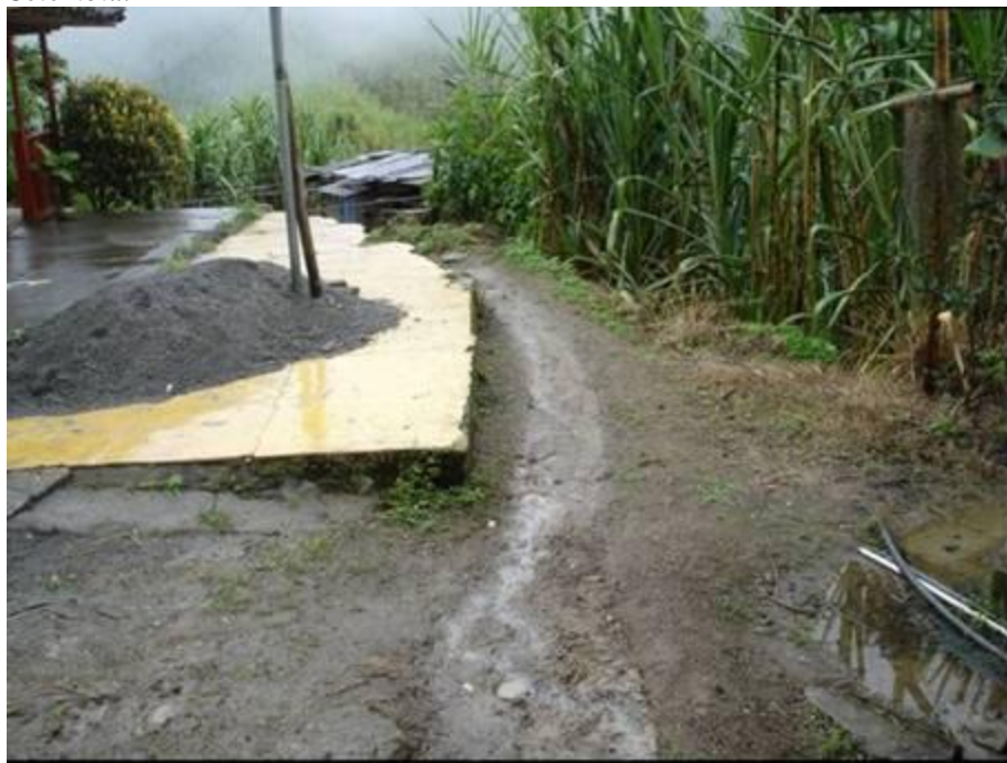
Figura 36. Parte frontal de la vivienda ubicada en la parte alta de la ladera. se observa el paso de las aguas de escorrentía provenientes del camino de penetración a la Vereda Balmoral, municipio de Filadelfia, Caldas, Colombia.
