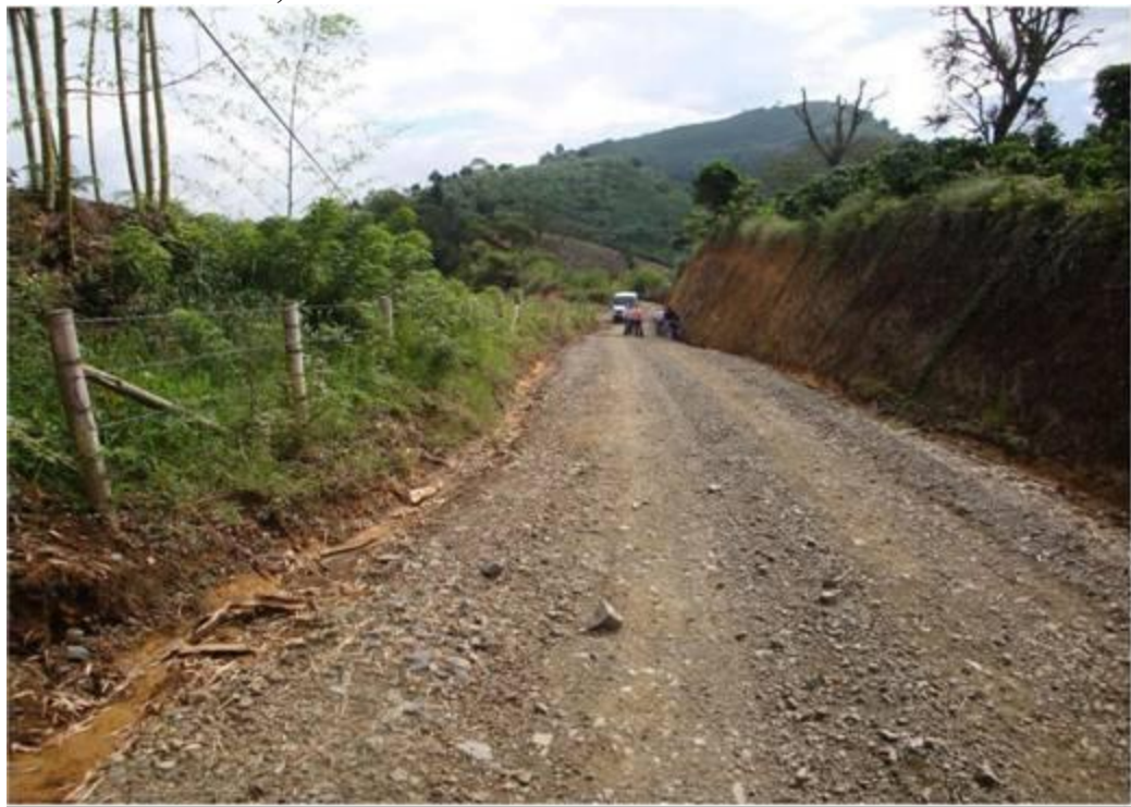
Figura 124. Estado de restauración y estabilización de la vía comparada a los nueve meses después de realizadas las obras. Noviembre de 2009. Vía carreteable que conduce de Pácora a San Bartolomé. Municipio de Pácora Vereda San Bartolomé, sector El Escobal.
