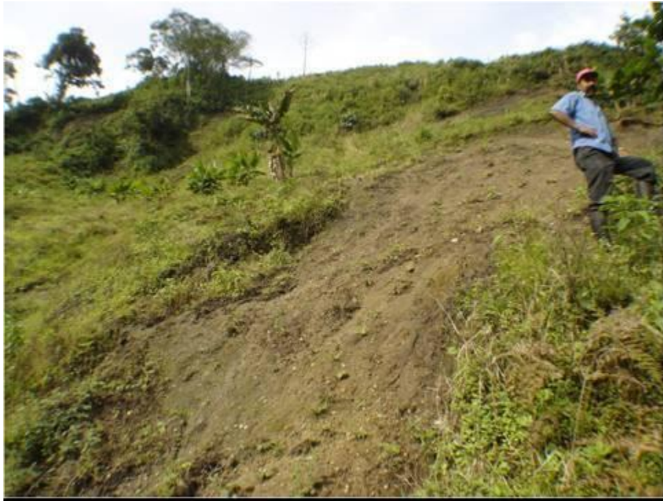
Figura 4. Se observa una pendiente mayor del 100% y longitud demasiado larga (mayor de 500 m), lo que favorece los procesos de erosión y los deslaves en toda la zona. Vereda Rio Claro viejo, Villamaría, Caldas. Marzo de 2008.
