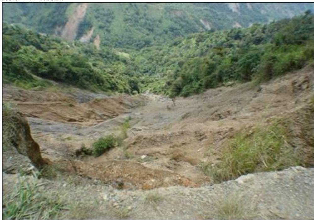
Figura 85. Se observa el efecto de cárcava remontante hacia la banca de la carretera. Marzo de 2008. Vía carreteable que conduce de Pácora a San Bartolomé. Municipio de Pácora Vereda San Bartolomé, sector El Escobal.
