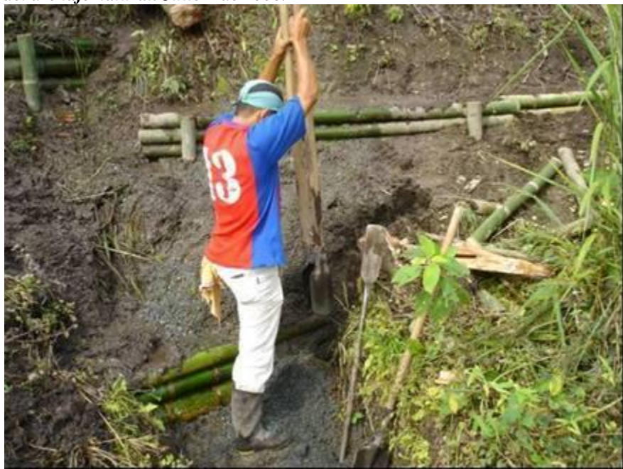
Figura 20. Iniciación de obras bio-ingenieriles en la Vereda río claro del municipio de Villamaría, Caldas, Colombia. Se observa la construcción del vertedero de una de las estructuras disipadoras de aguas de escorrentía del drenaje natural. Julio 1 de 2008.
