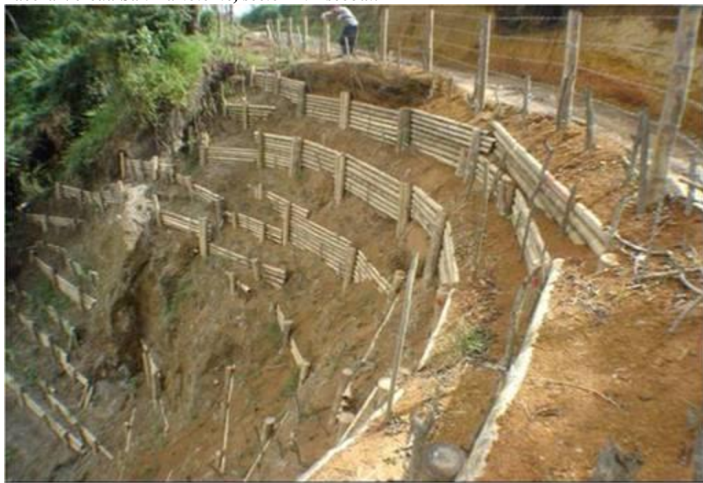
Figura 102 Sector 1. Avances en la estabilización y restitución de parte de la banca de carretera, mediante la construcción de trinchos vivos escalonados. Corregimiento de San Bartolomé, sector El Escobal, municipio de Pácora, Caldas. Diciembre de 2008. Vía carretable que conduce de Pácora a San Bartolomé. Municipio de Pácora Vereda San Bartolomé, sector El Escobal.
