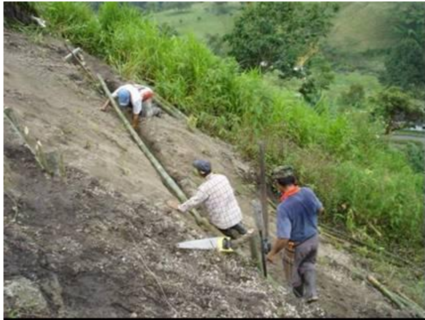
Figura 18. Colocación de las guaduas dentro de la zanja, con el fin de conformar un trincho que no sea socavado fácilmente por las aguas de escorrentía, evitando que la estructura quede en el aire y sin función alguna.
