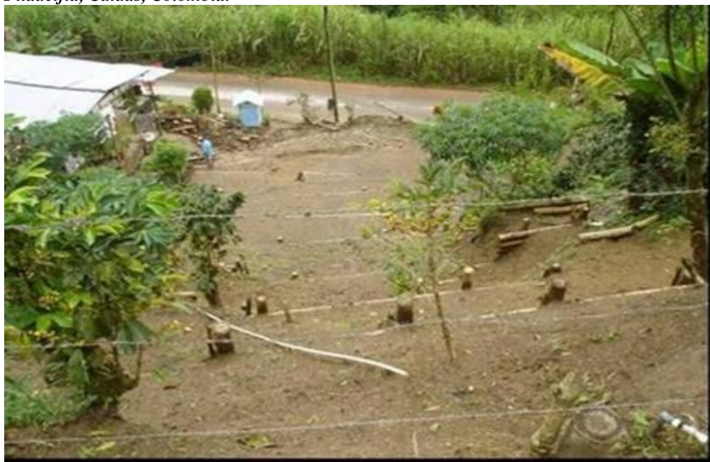
Figura 75. Trabajos culminados. Vista de arriba hacia abajo (octubre de 2008). Vereda Balmoral municipio de Filadelfia, Caldas, Colombia.
