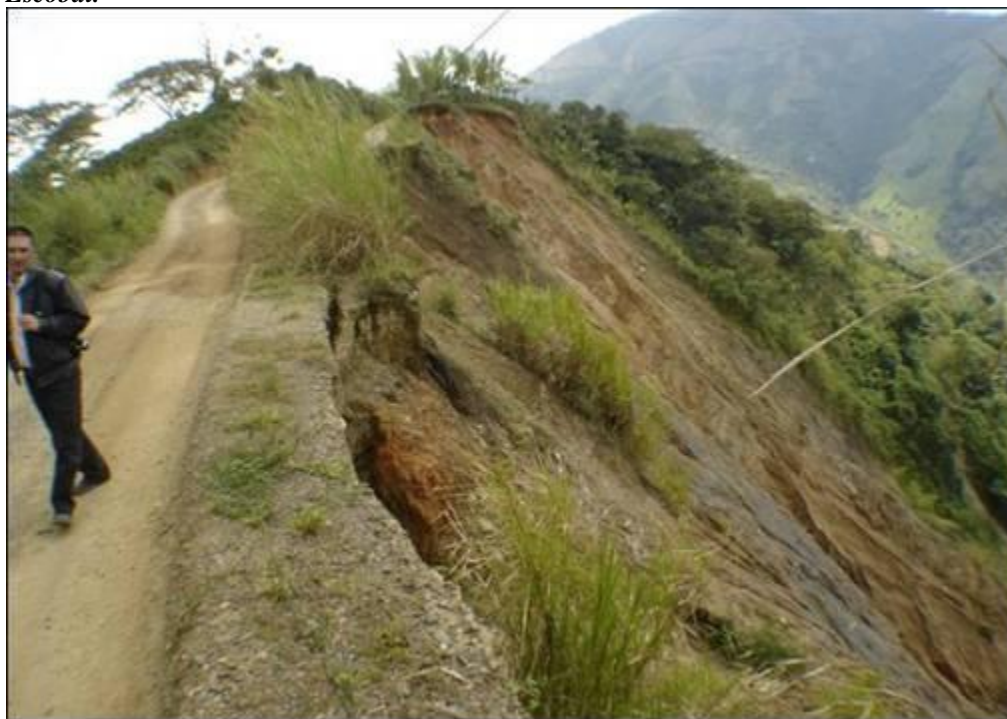
Figura 85. Se observa el efecto de cárcava remontante hacia la banca de la carretera. Marzo de 2008. Vía carreteable que conduce de Pácora a San Bartolomé. Municipio de Pácora Vereda San Bartolomé, sector El Escobal.
