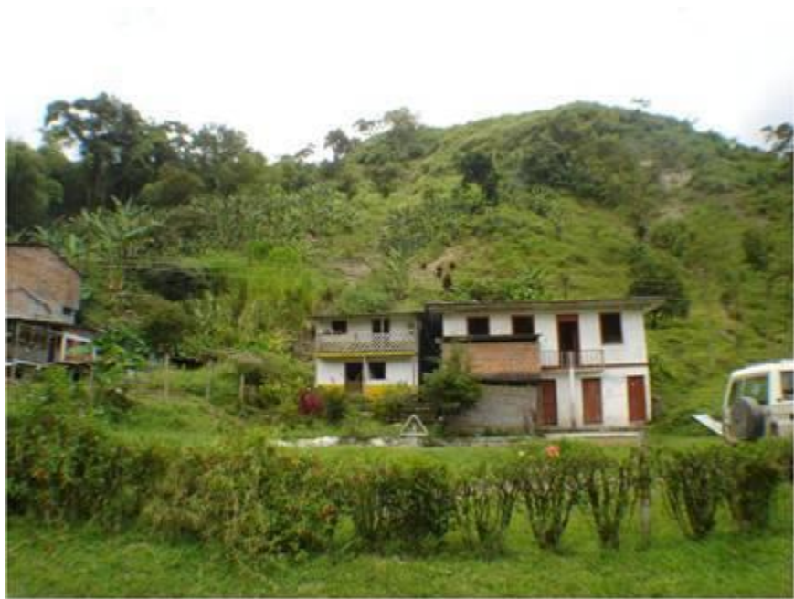
Figura 10. Presencia de deslaves en la ladera, causantes daños en las viviendas ubicadas aguas abajo. Julio de 2008.
