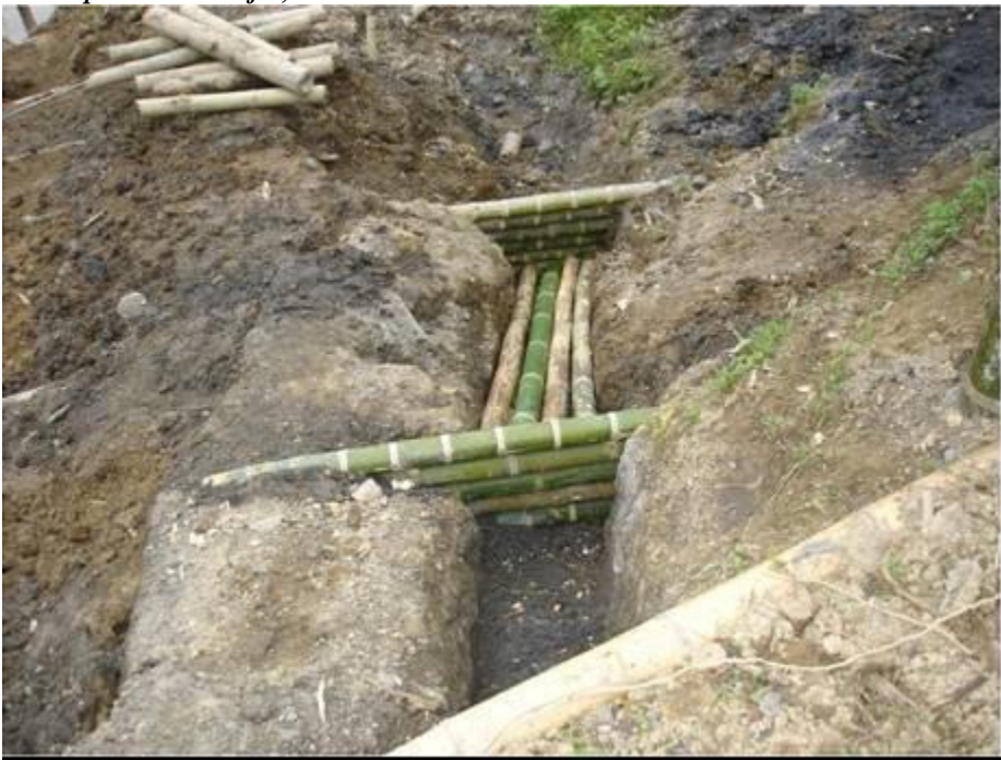
Figura 68. Sección de filtro complementado con dos trinchos vivos en guadua (agosto 2008). Vereda Balmoral municipio de Filadelfia, Caldas
