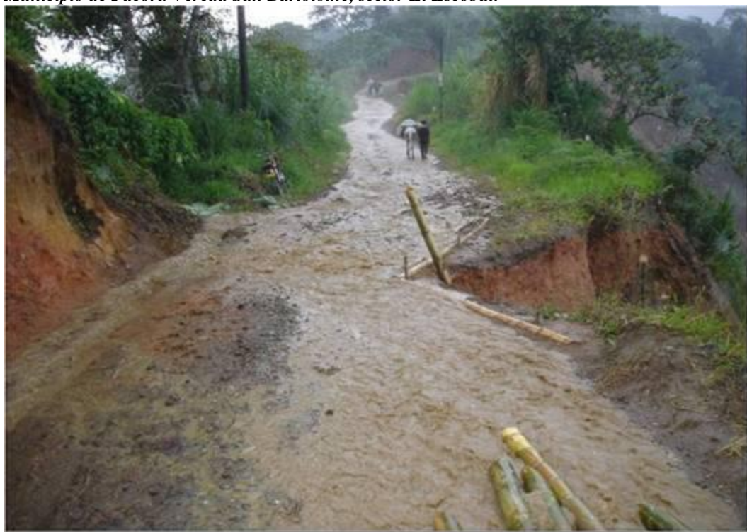
Figura 97. Sitio donde se concentran grandes caudales de aguas de escorrentía provenientes de la carretera. Municipio de Pácora Vereda San Bartolomé, sector El Escobal.
