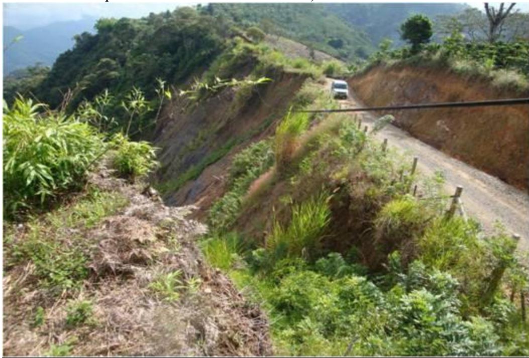
Figura 122. Restauración de cárcava profunda, con la construcción de trinchos vivos escalonados, complementados con estacas vivas de matarratón. Mayo de 2010. Vía carretable que conduce de Pácora a San Bartolomé. Municipio de Pácora Vereda San Bartolomé, sector El Escobal.
