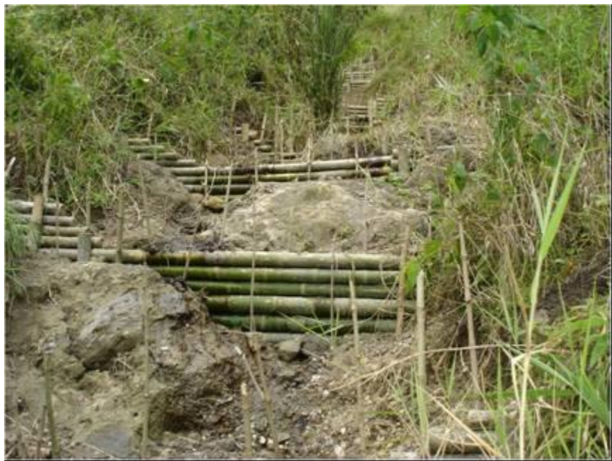
Figura 20. Iniciación de obras bio-ingenieriles en la Vereda río claro del municipio de Villamaría, Caldas, Colombia. Se observa la construcción del vertedero de una de las estructuras disipadoras de aguas de escorrentía del drenaje natural. Julio 1 de 2008.
