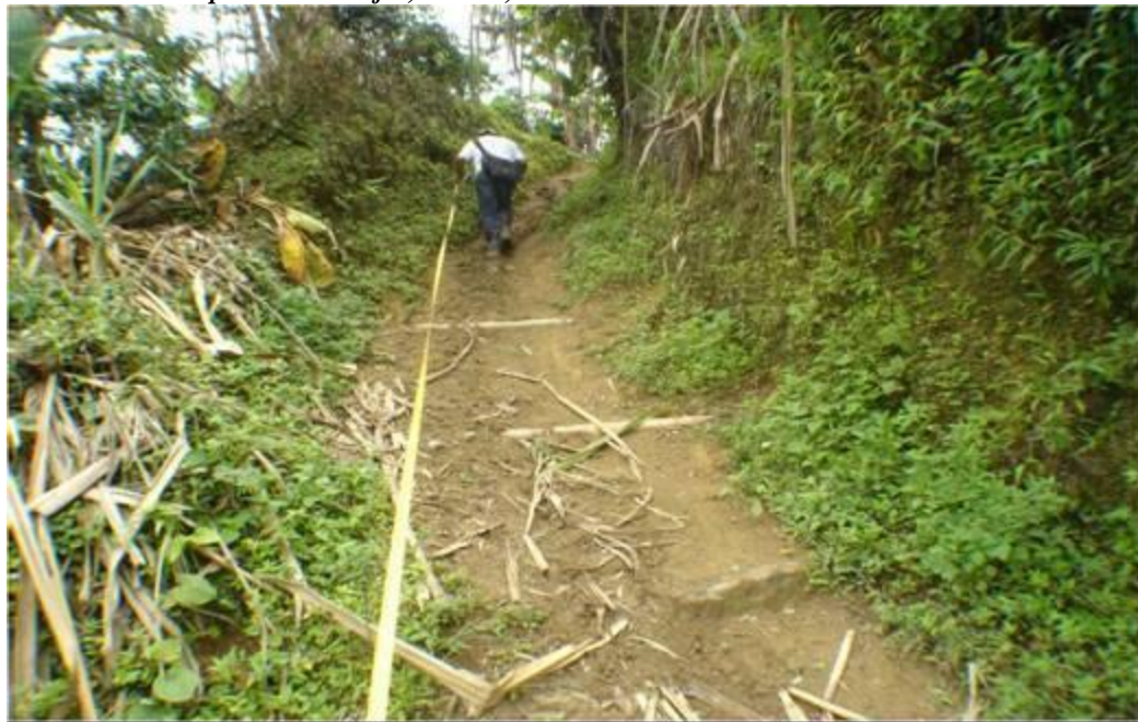
Figura 55. Disipadores simples de energía para disminución de la energía cinética de las aguas de escorrentía que avanzan camino abajo en períodos lluviosos. Estos disipadores son contruidos en guadua rolliza. Vereda Balmoral municipio de Filadelfia, Caldas, Colombia.
