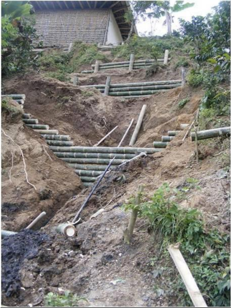
Figura 69. Sistema de trinchos vivos escalonados y filtros enterrados (julio de 2008). Vereda Balmoral municipio de Filadelfia, Caldas, Colombia.
