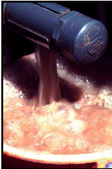
**Figura 25.** Entrada de las aguas mieles a la trampa de pulpas a través de la válvula de descarga.
