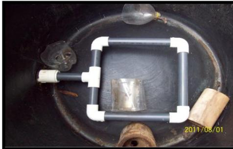
**Figura 42.** Dispositivo interno de distribución de flujo en el reactor metanogénico.
