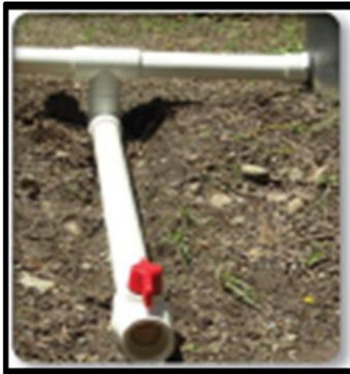
**Figura 30.** Tubería de entrada al primer tanque hidrolítico.
