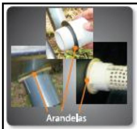
**Figura 28.** Ubicación de las arandelas de neo lite entre las paredes del tanque y los dispositivos instalados.
