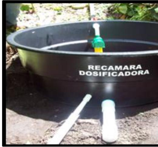
**Figura 35.** Accesorios internos y externos de la recámara dosificadora.
