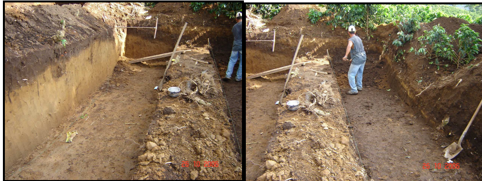
Figura 20. Excavaciones humedales flujo libre y subsuperficial
