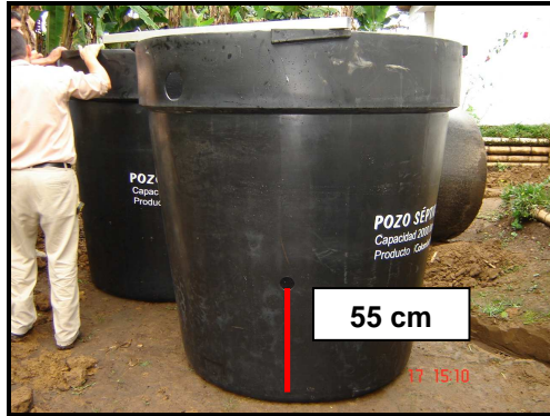
Figura 36. Tanque séptico perforado para evacuación de lodos
