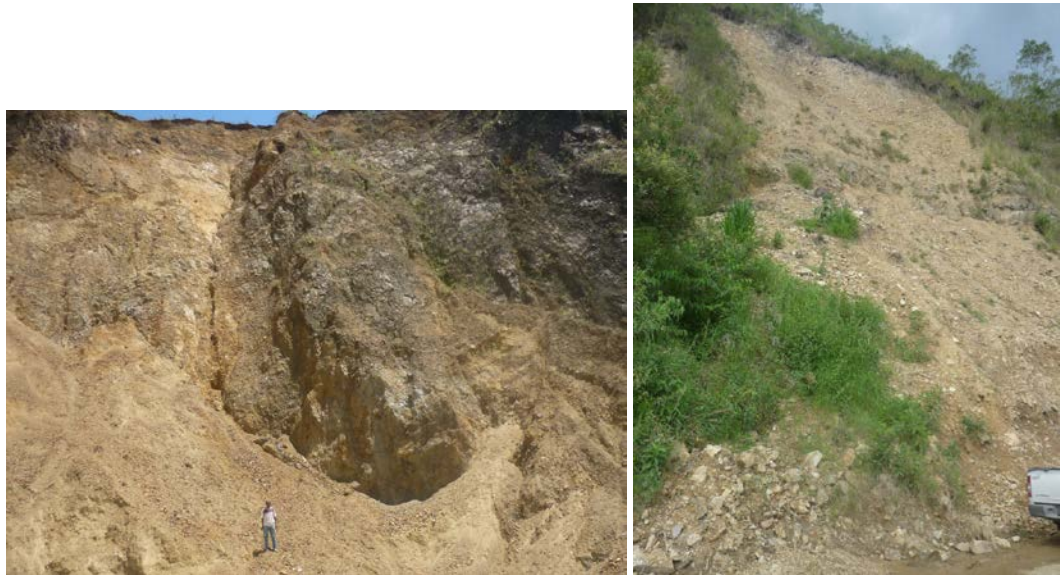
Figura 4. IZQ. Deslizamiento en Aguadas, Caldas, sector La Cruz. DER. Deslizamiento en la vía que conduce a Salamina, Caldas
