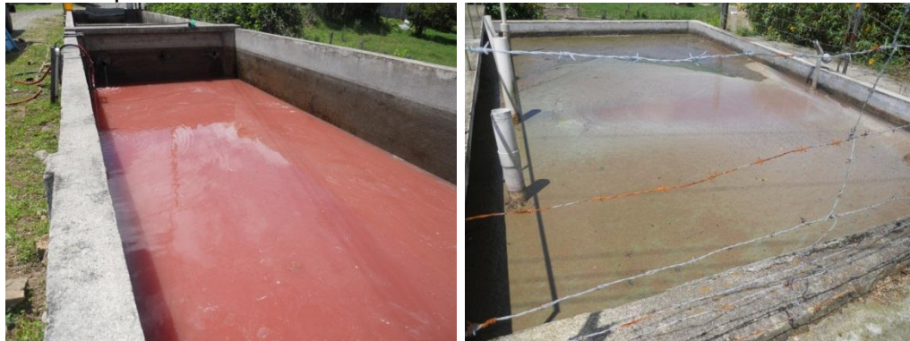
Figura 4. Tanques de sedimentación
