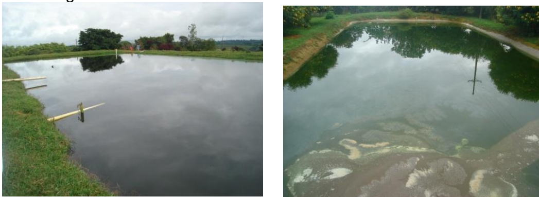
Figura 5. Lagunas de oxidación
