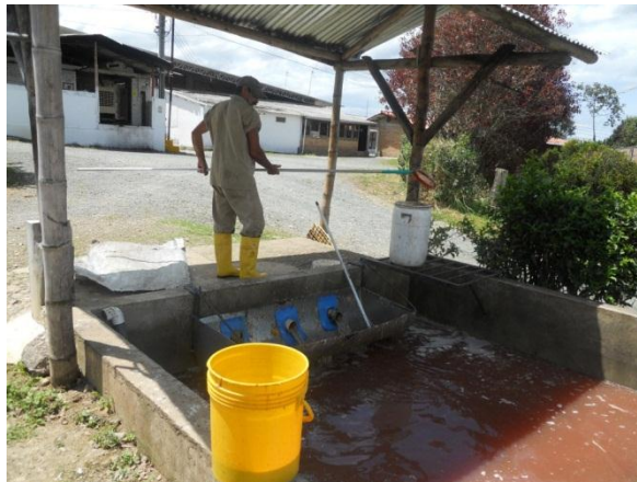
Figura 1. Operario retirando residuos sólidos a la entrada de P.T.A.R.
