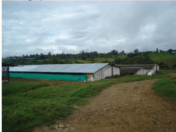
Figura 3. Vista exterior de galpón
