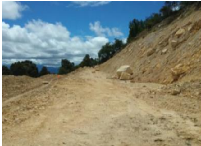
Imagen 2 Adecuación morfológica estabilización de taludes y bermas
