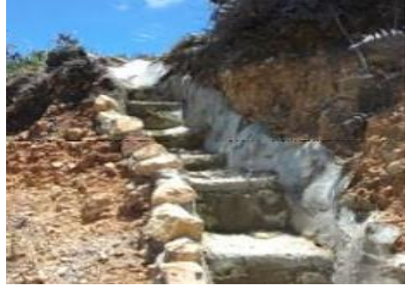
Imagen 6 Disipadores de energía
