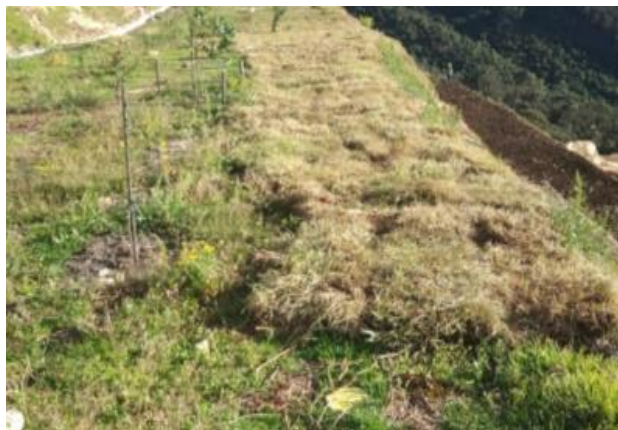
Imagen 8 Conformación de bermas de los taludes
