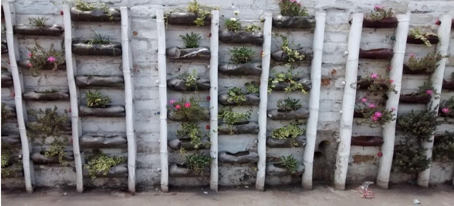
Fotografía 1: Agricultura Urbana en muro de la comunidad Miraflores.
